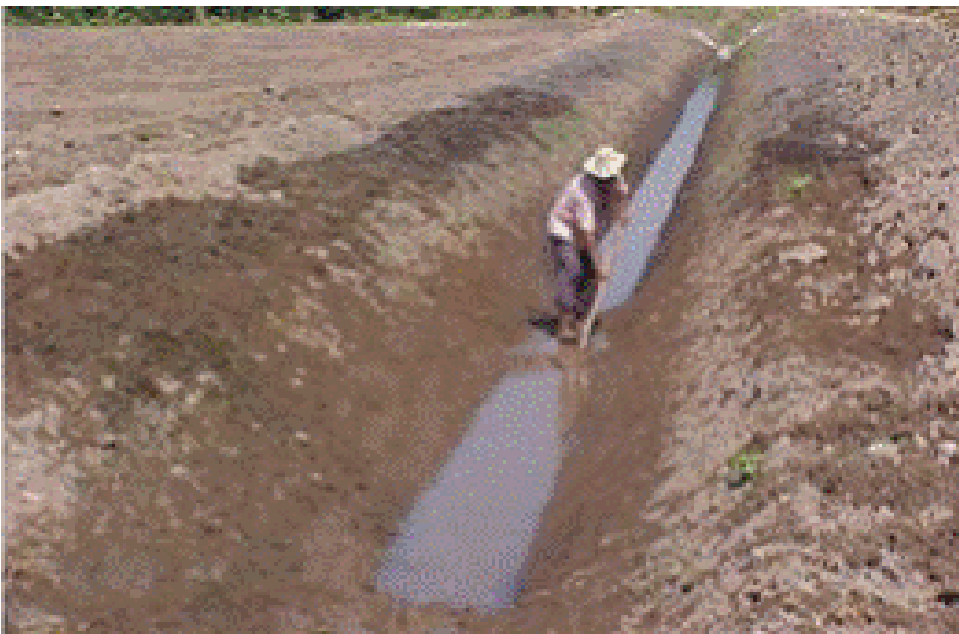
Figura No 3. Construcción de Drenajes Secundarios
