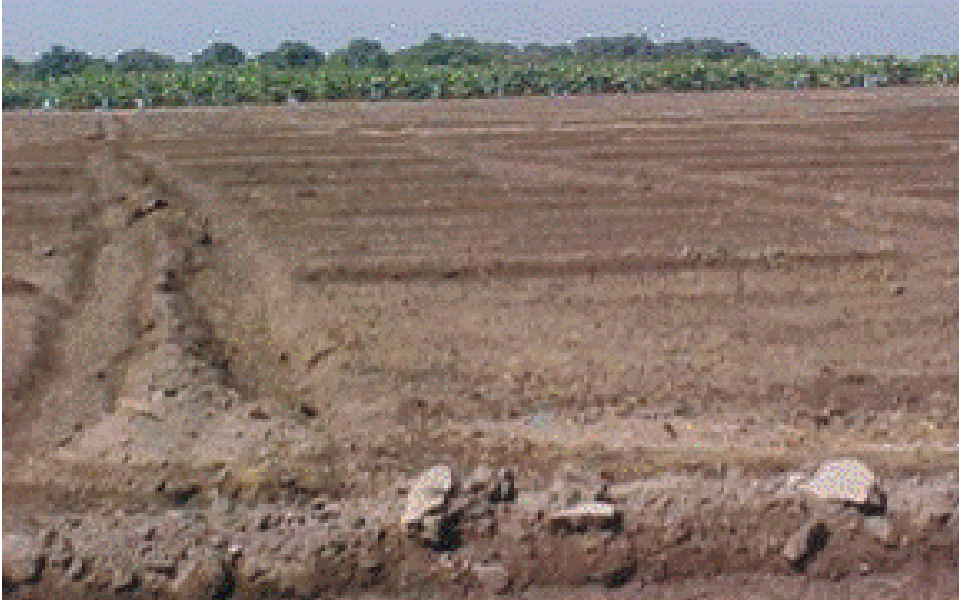
Figura No 2. Construcción de Drenajes Primarios
