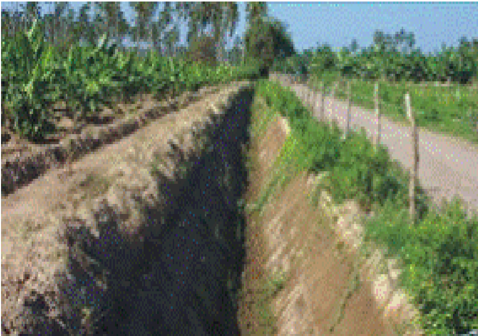
Figura No 5. Apertura de Drenajes
