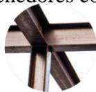
7. Estructura metalica con perfiles H200 de 10mm de espesor.
