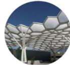
4. Pergola exagonal, de acero al carbon, tubos rectangulares de 25mm X 60mm y acrilico semitransparente color verde olivo, Pintura acabado maderado.
