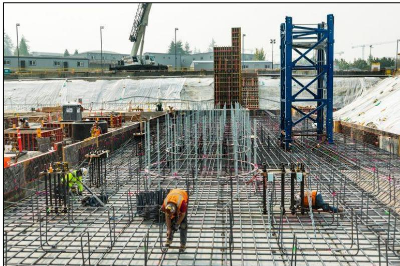
**Figura 10 Armado De Estructura Para Losas Y Muros Para Construcción Del Campus Microsoft**
