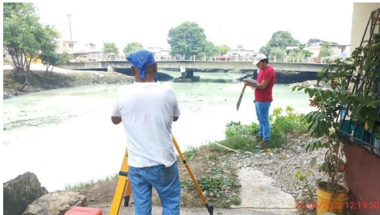
*Ilustración 8: Levantamiento Topográfico del Estero Salado.*
