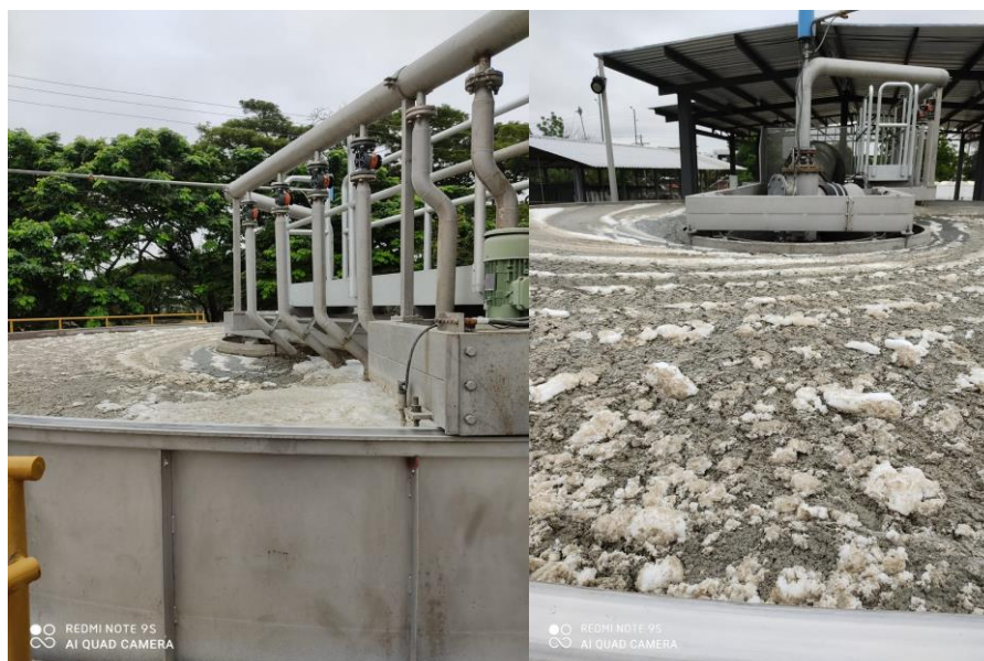
Nota: Piscina de lodos
