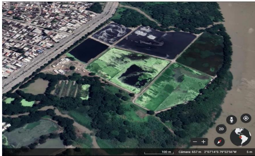
Nota: Ubicación de la PTAR Figura 13: PTAR Los Merinos
