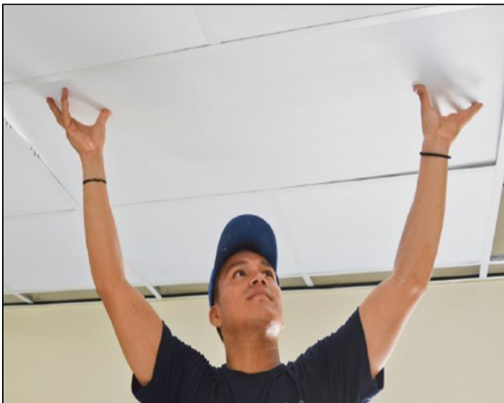
Figura 10. Cielo raso desmontable Elaborado por: Álvarez, C. (2022)
