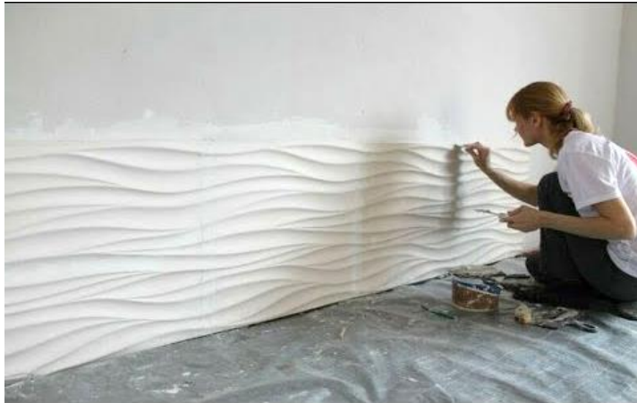
Figura 37. Instalación panel de yeso a la pared Elaborado por: Álvarez, C. (2022)
