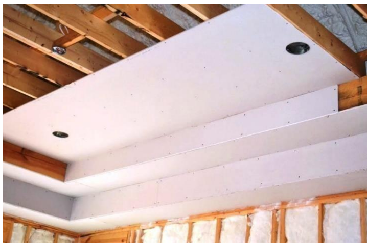
Figura 7. Instalación de paneles de techo falso de yeso con características termoacústicas Elaborado por: Álvarez, C. (2022)
