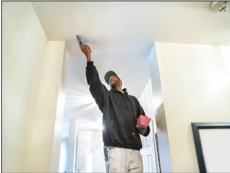
Figura 11. El cielorraso protege del calor y del frío Elaborado por: Álvarez, C. (2022)
