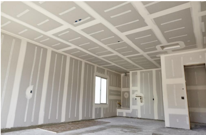
Figura 5. Instalación de paneles de yeso y paneles termo acústicos de techo Elaborado por: Álvarez, C. (2022)
