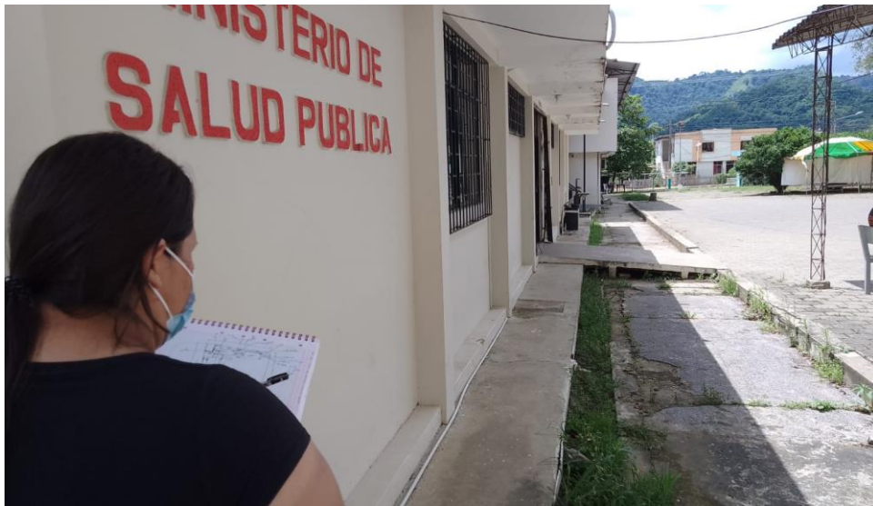
Figura 59: Perspectiva de la fachada frontal
