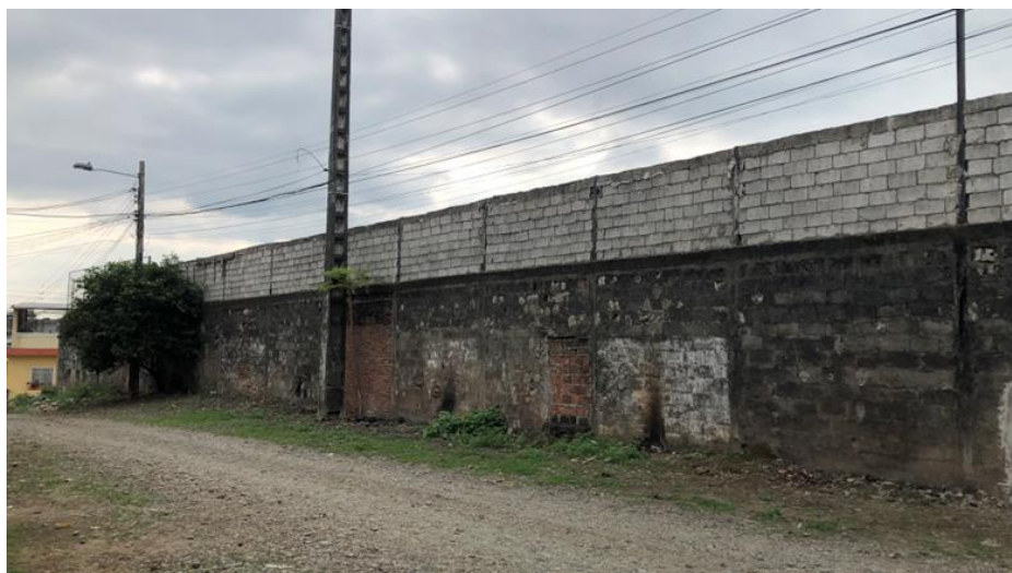
Calle Azuay (Fachada lateral izquierda)
