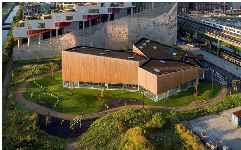
Figura 13. Vista aérea del Complejo Deportivo y Comunitario Polivalente. Fuente: (Mork, 2017).
