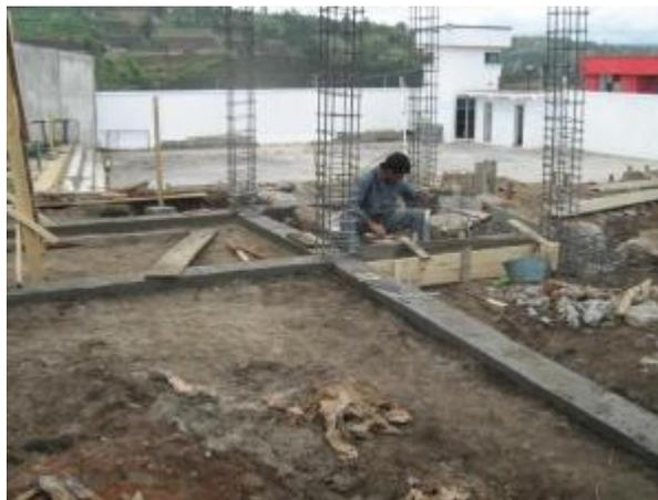
**Figura 4.** Construcción de vigas de cimentación
