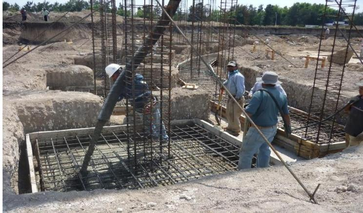
**Figura 3.** Construcción de zapatas
