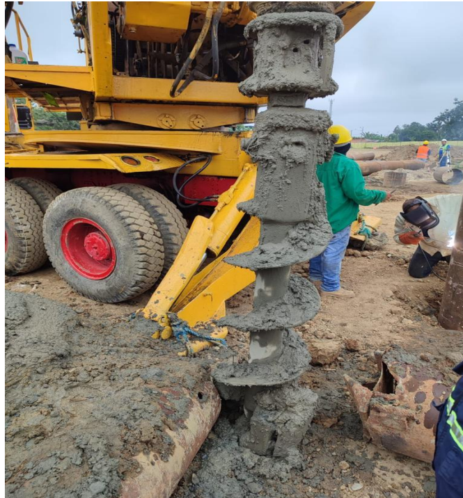
Figura 10: Perforación de uno de las tomas de muestra en las Lagunas Elaborada por Zea, M. (2022)
