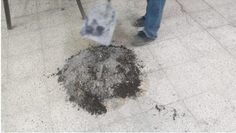
**Figura 25:** Preparación de hormigón para bloques con adición de concha de coco
