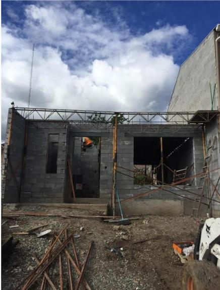
**Figura 25:** Colocación de bloque para conformar paredes sobre losa de cimentación sistema boonker en fachada de vivienda
