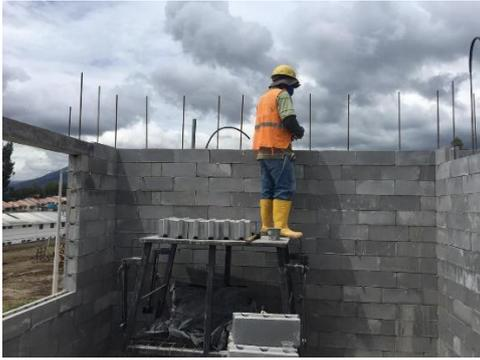
**Figura 23:** colocación de bloque para conformar paredes sobre losa de cimentación sistema boonker
