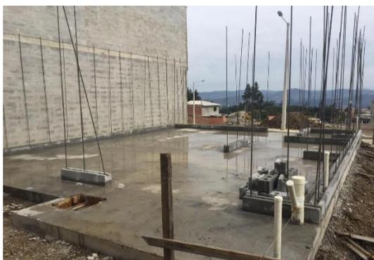
**Figura 20:** Hormigón en losa de cimentación sistema boonker
