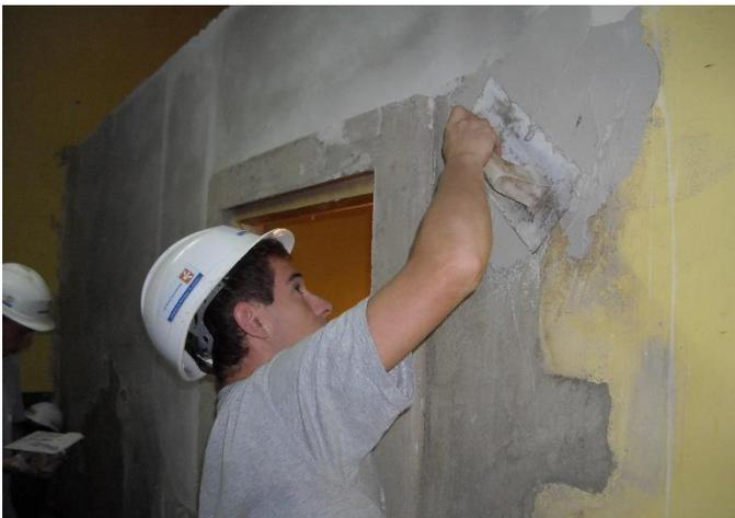
**Figura 18:** Enlucido de pared con mortero 1:3 arena, cemento, agua
