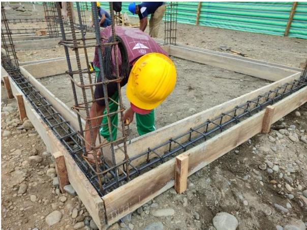
**Figura 13:** Encofrado con acero de refuerzo estribos en riostras, columnas
