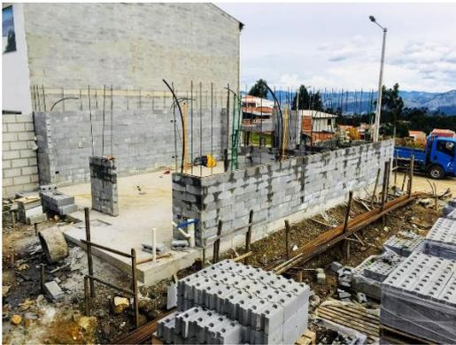
**Figura 22:** Colocación de bloque sobre losa de cimentación sistema boonker(2)
