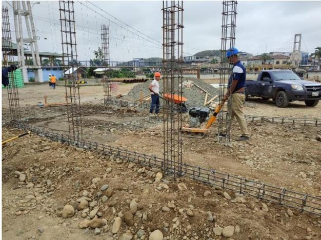
**Figura 12:** Rubro acero de refuerzo estribos para columna y riostras.
