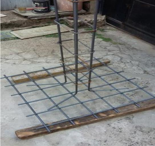
**Figura 10:** Rubro acero de refuerzo en parrilla de plinto y columna
