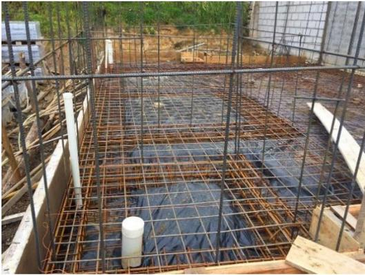
**Figura 19:** Estructura de acero para losa de cimentación sistema boonker
