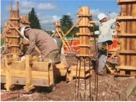
**Figura 8:** Rubro encofrado para columnas.
