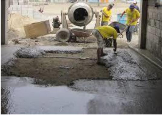
**Figura 17:** Fundición de contrapiso
