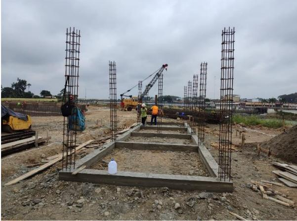
**Figura 14:** Hormigón armado con acero de refuerzo estribos en riostras, columnas
