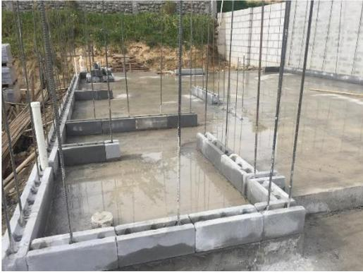
**Figura 21:** colocación de bloque sobre losa de cimentación sistema boonk
