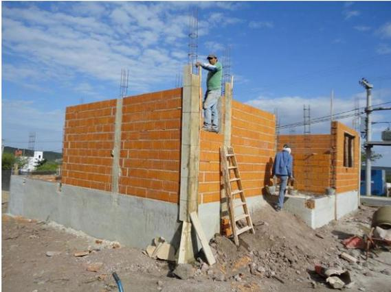
**Figura 15:** Hormigón armado con acero de refuerzo estribos en riostras, columnas
