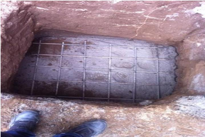
**Figura 6:** Rubro replantillo con hormigón simple de baja resistencia
