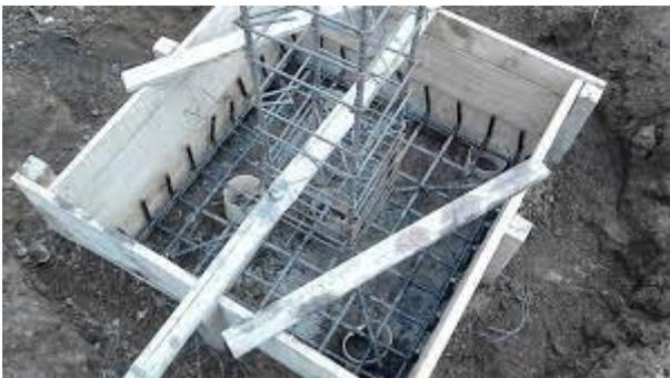
**Figura 7:** Rubro encofrado para plintos
