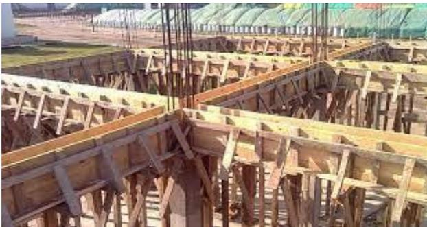
**Figura 9:** Rubro encofrado para vigas
