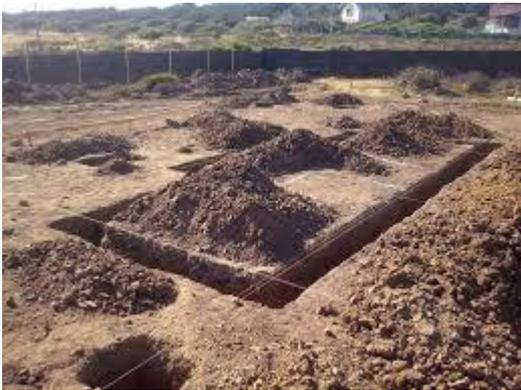
**Figura 5:** Rubro excavación en cimientos manualmente
