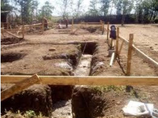
**Figura 4:** Rubro excavación en cimientos manualmente
