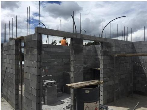
**Figura 24:** Colocación de bloque para conformar paredes de división sobre losa de cimentación sistema boonker.
