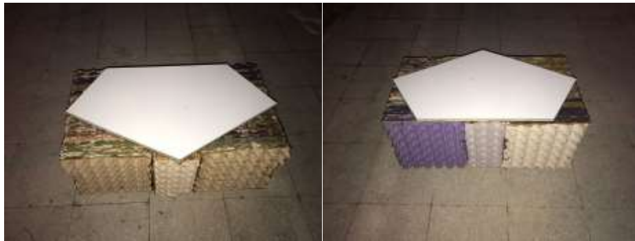
Figura 21. Colocación del tablero de RH
