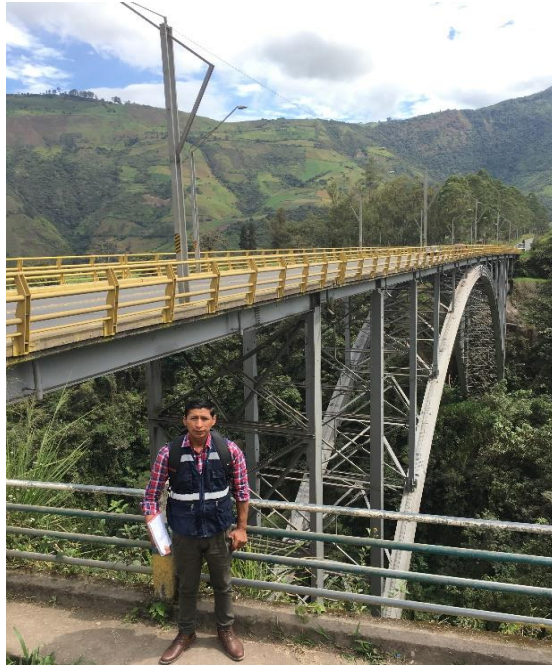
Figura 2. Vista puente “Cornelio Dávalos” actual Elaborado por: Buñay, J. (2022)
