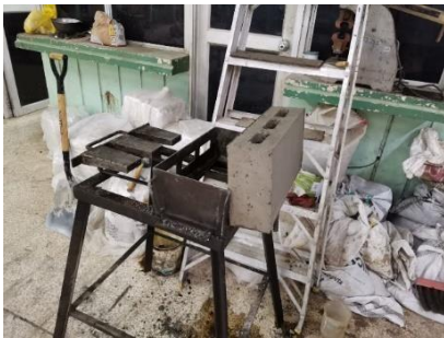
Figura 22. Bloque elaborado en molde de acero.
