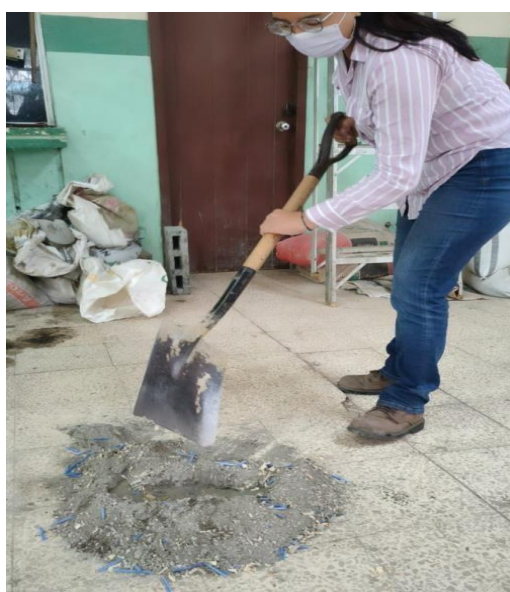
Foto 27: Mezcla antes de agregar agua. Elaborado por: Lara, R. y Mejía, N. (2022)
