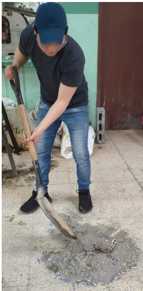
Foto 26: Mezcla de los agregados. Elaborado por: Lara, R. y Mejía, N. (2022)
