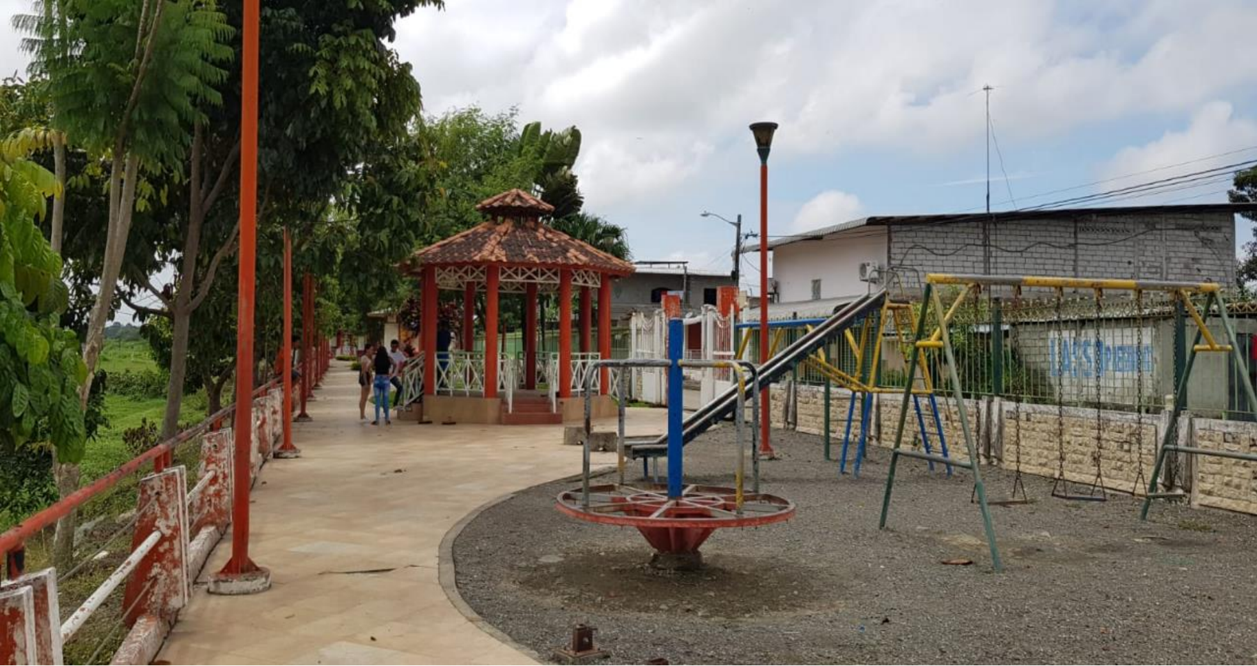
Anexo 8: Estado actual del malecón de la parroquia Palestina
