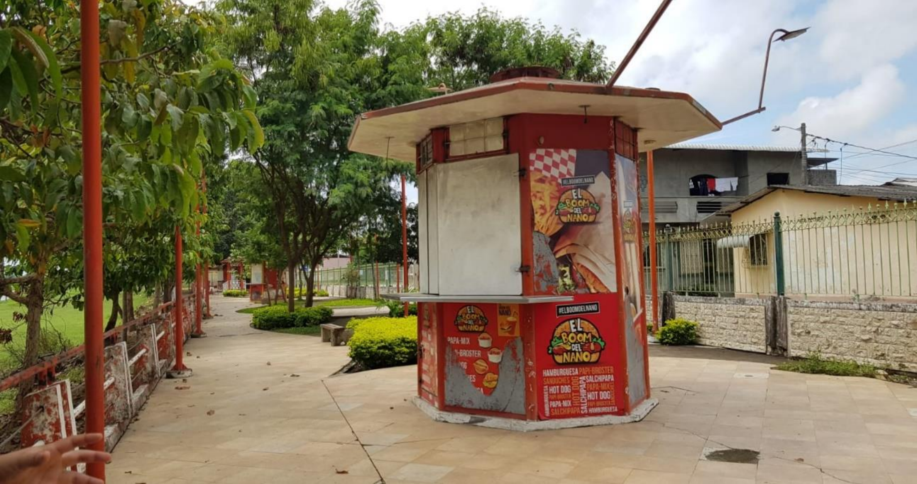
Anexo 10: Estado actual del malecón de la parroquia Palestina.
