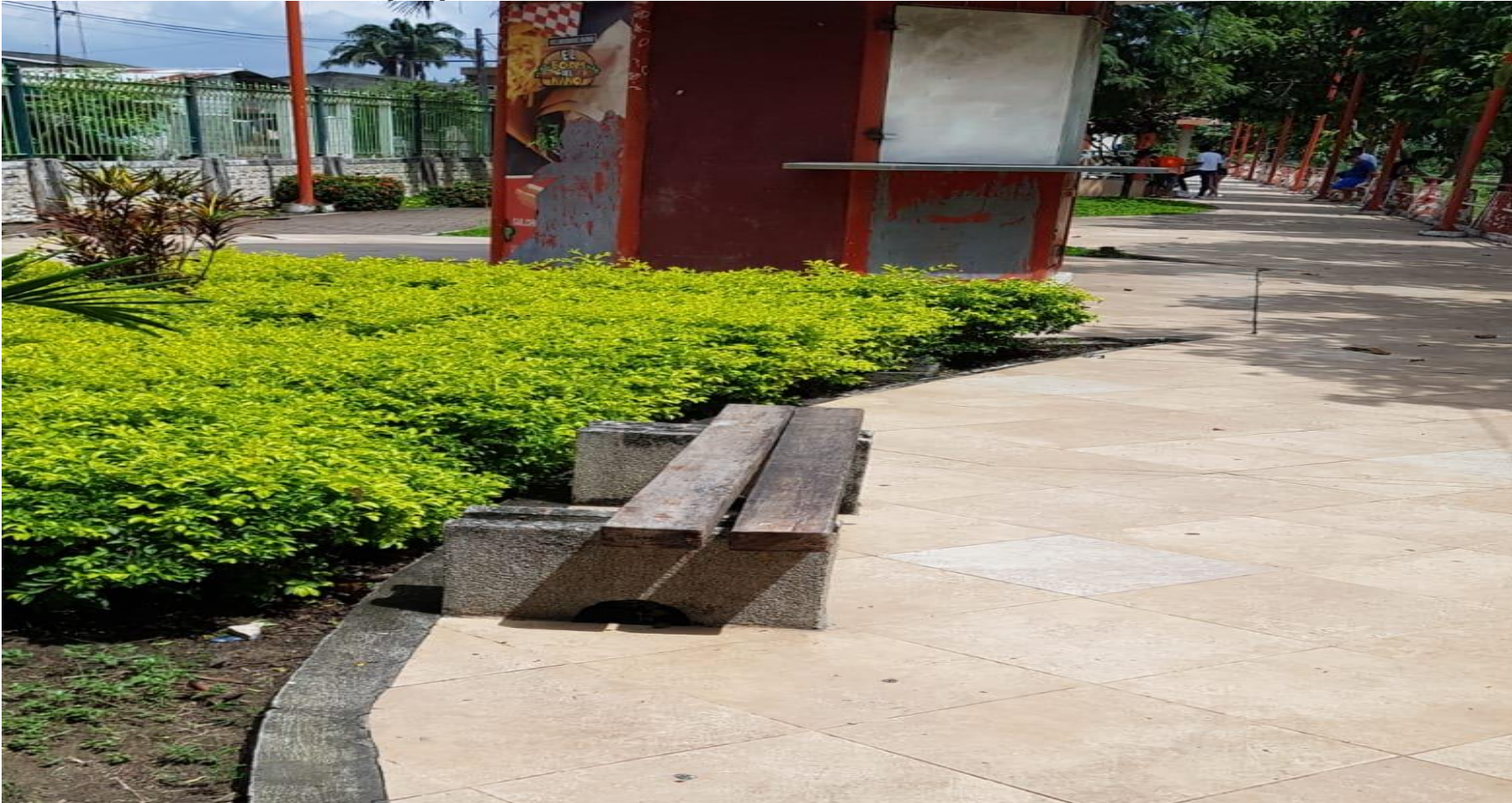
Anexo 11: Estado actual del malecón de la parroquia Palestina
