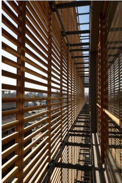
**Figura 10:** Cavity Intermedia del sistema doble piel.
