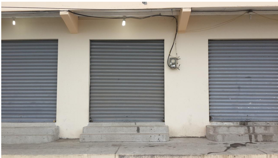
LOCAL DEL CENTRO DE CAPACITACION SANTA ELENA
