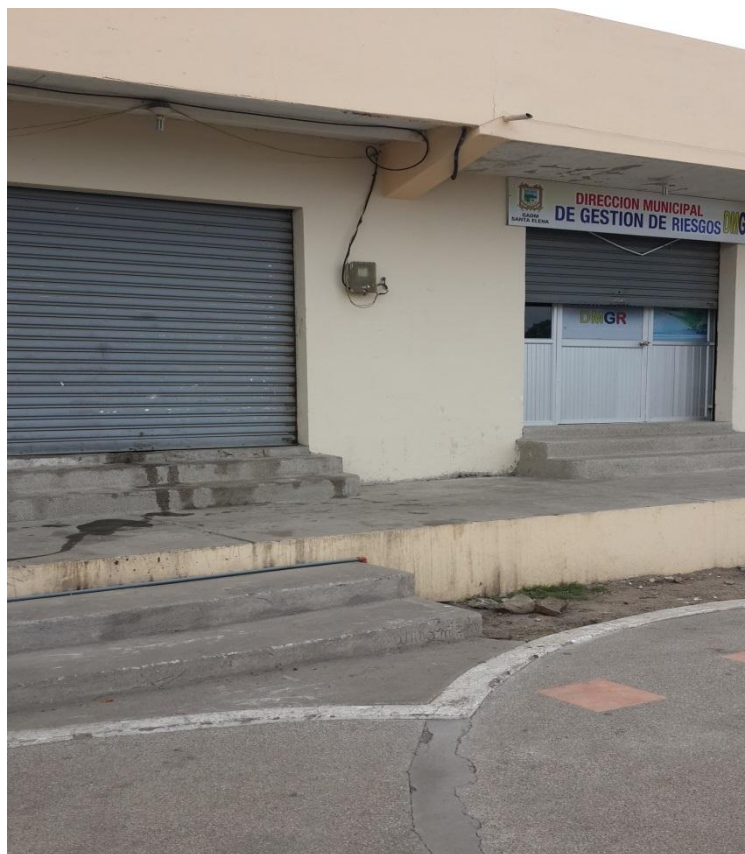
LOCAL DEL CENTRO DE CAPACITACION SANTA ELENA
