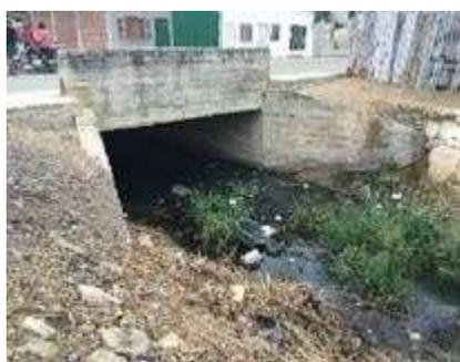
Figura 12. Alcantarilla “F-2” tipo ducto cajón
