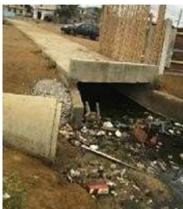
Figura 10. Alcantarilla “E-3” tipo ducto cajón
