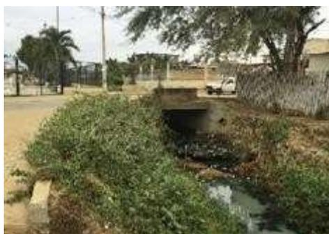
Figura 8. Alcantarilla "B-1" tipo Ducto cajón.
