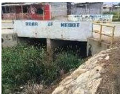
Figura 11. Alcantarilla “F-1” tipo ducto cajón doble
