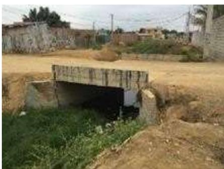
Figura 9. Alcantarilla “E-2” tipo ducto cajón
