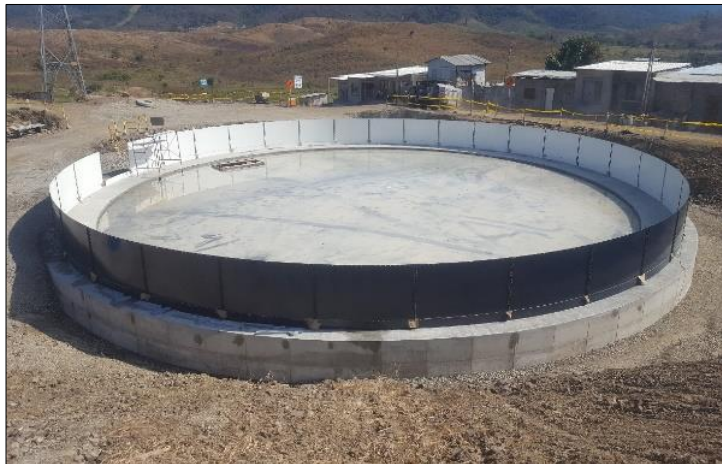
Figura 39. Armado del primer anillo de láminas de vidrio Fuente: EMAPAG E.P.
