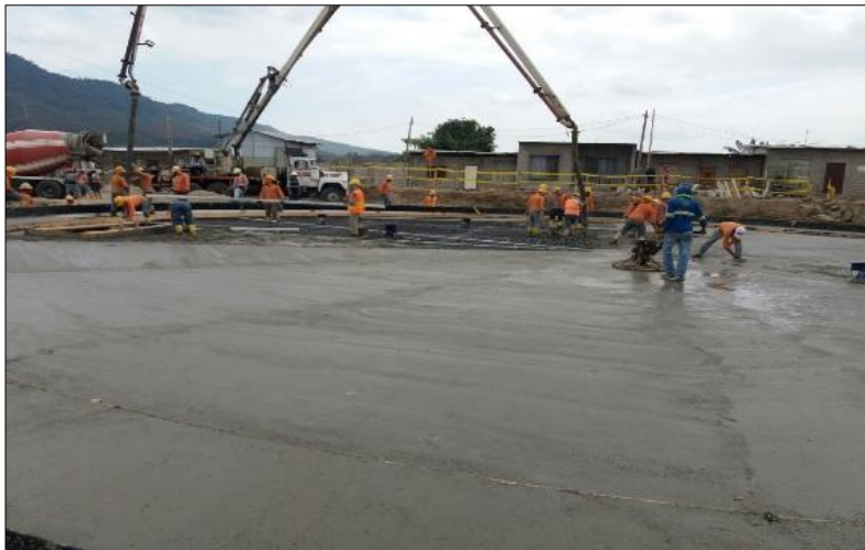
Figura 34. Colocación del piso de concreto. Fuente: EMAPAG E.P.
