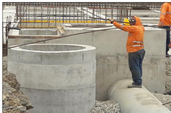
Figura 19. Instalación de armadura para estructura Fuente: EMAPAG E.P.
