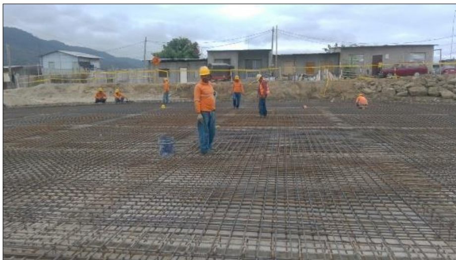
Figura 31. Refuerzo de acero para el equilibrio. Fuente: EMAPAG E.P.
