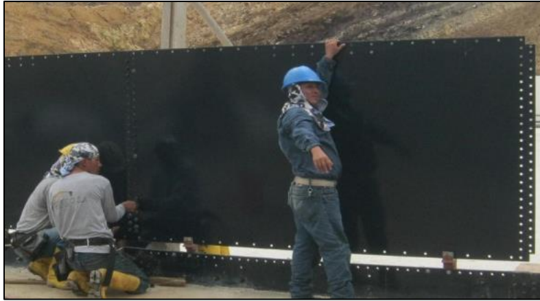
Figura 3. Colocación de láminas de vidrio fusionado al acero. Fuente: EMAPAG-E.P.
