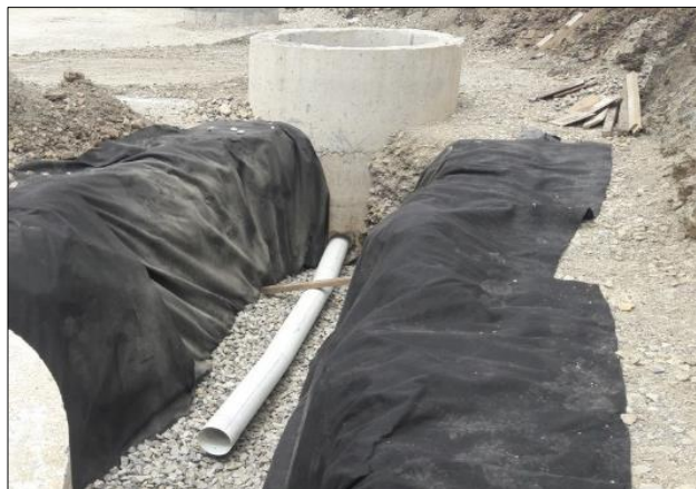
Figura 14. Colocación de piedra triturada Fuente: EMAPAG-EP.
