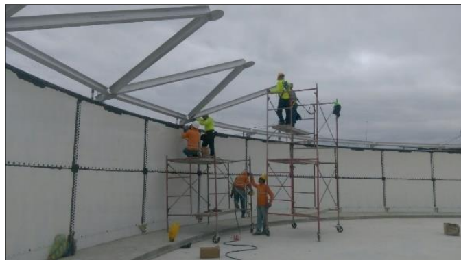
Figura 40. Construcción del domo de aluminio. Fuente: EMAPAG E.P.
