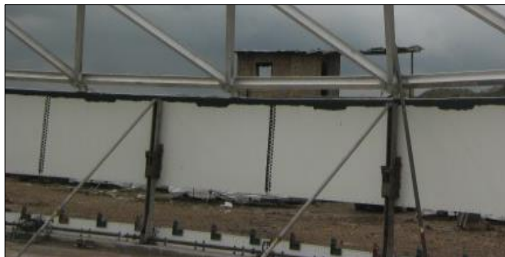
Figura 30. Gatas Hidráulicas para levantar los anillos. Fuente: EMAPAG-EP.
