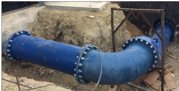
Figura 5. Tee de acero bridado \varnothing 400\text{mm} Fuente: EMAPAG-E.P.
