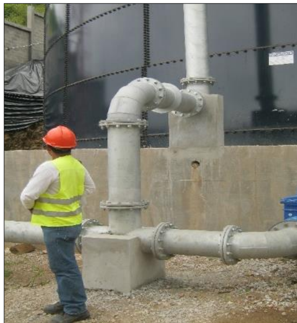
Figura 27. Bloques de anclaje para tuberías. Fuente: EMAPAG E.P.
