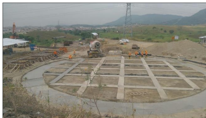
Figura 17. Replanteo para la cimentación del reservorio Fuente: EMAPAG E.P.
