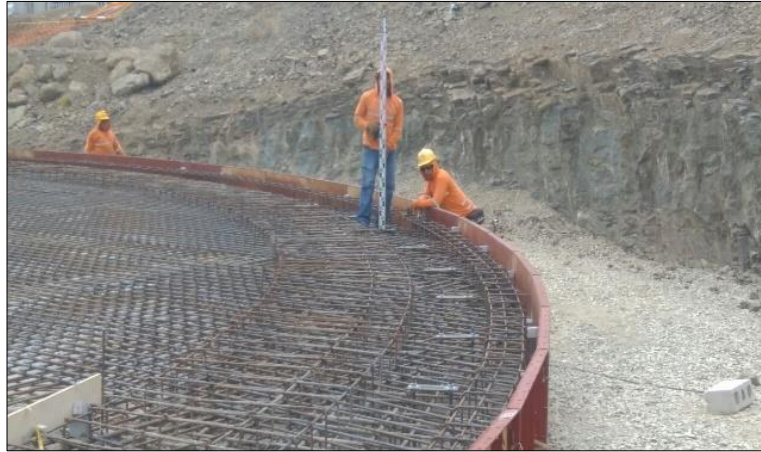
Figura 32. Nivelación de los anclajes niveladores de anillo. Fuente: EMAPAG E.P.
