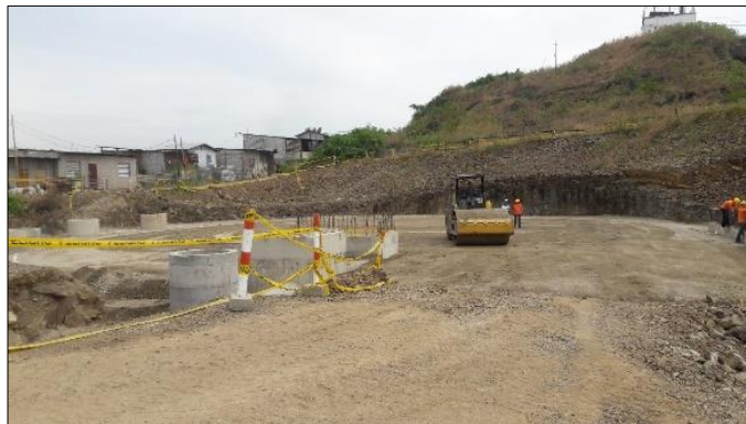
Figura 15. Colocación de relleno Fuente: EMAPAG-EP.
