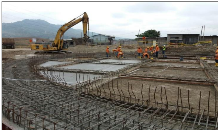
Figura 20. Armadura para la cimentación del reservorio Fuente: EMAPAG E.P.
