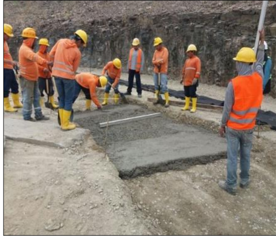
Figura 18. Construcción del replantillo Fuente: EMAPAG E.P.
