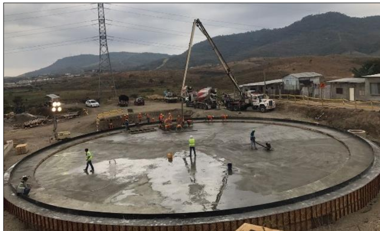
Figura 26. Curado del hormigón. Fuente: EMAPAG E.P.
