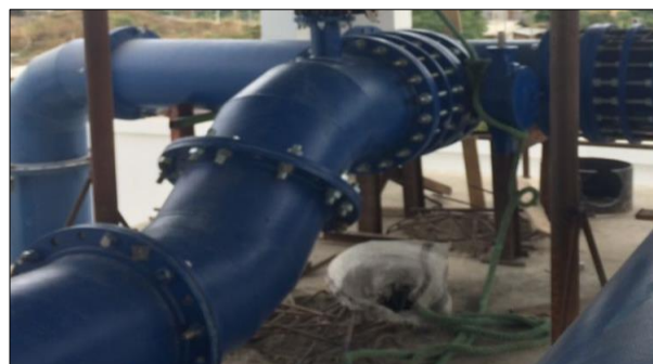
Figura 8. Accesorios de acero bridado. Fuente: EMAPAG-E.P.
