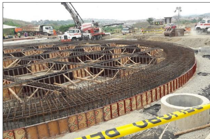
Figura 21. Viga para la cimentación del reservorio. Fuente: EMAPAG E.P.
