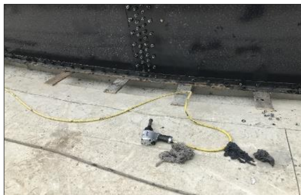
Figura 37. Láminas de vidrio empernadas. Fuente: EMAPAG E.P.
