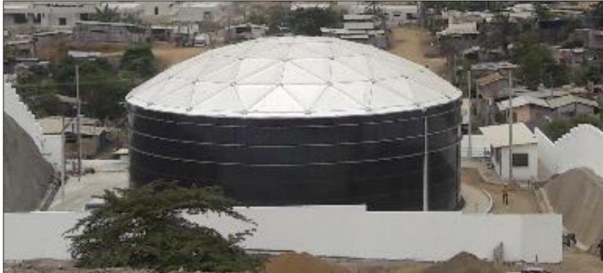
Figura 41. Construcción del reservorio completo. Fuente: EMAPAG-E.P.
