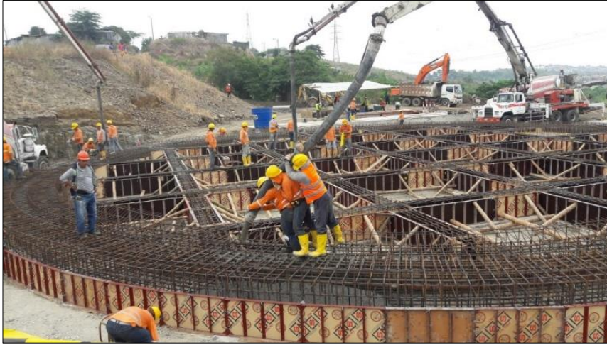
Figura 22. Colocación del hormigón premezclado. Fuente: EMAPAG E.P.
