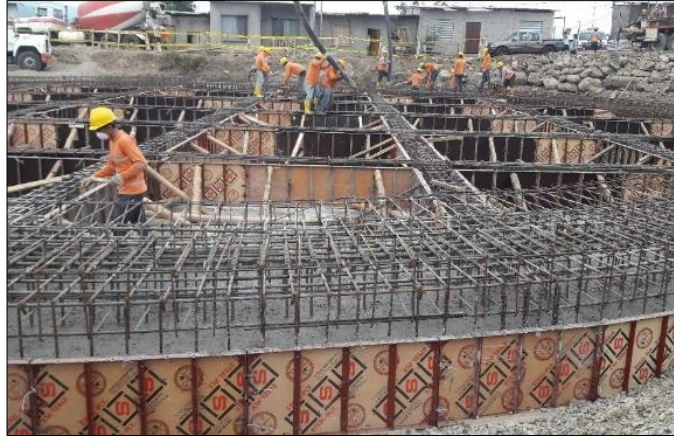
Figura 25. Recubrimiento mínimo de armaduras. Fuente: EMAPAG E.P.
