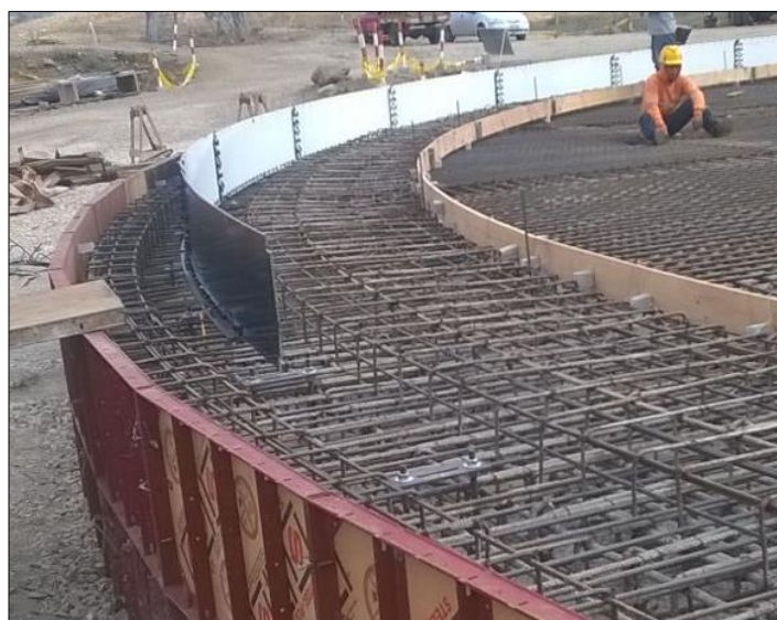
Figura 33. Colocación de la primera hoja de cimentación. Fuente: EMAPAG E.P.
