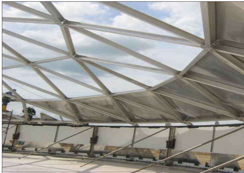
Figura 38. Gatos para levantar el domo. Fuente: EMAPAG E.P.
