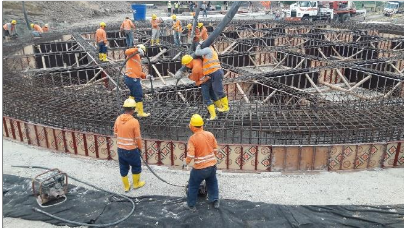
Figura 24. Vaciado del hormigón. Fuente: EMAPAG-E.P.
