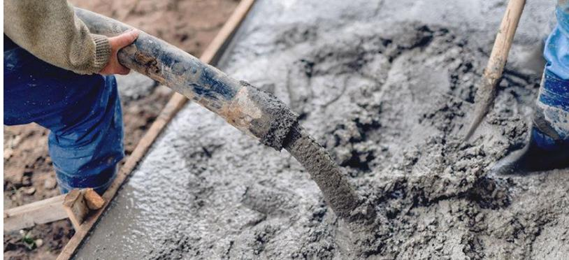
**Figura 7:** Vaciado de Hormigón o concreto en losa
