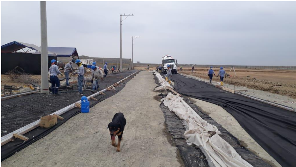
Imagen 47. Colocación de geotextil Elaborado por. Pozo, C. (2021)
