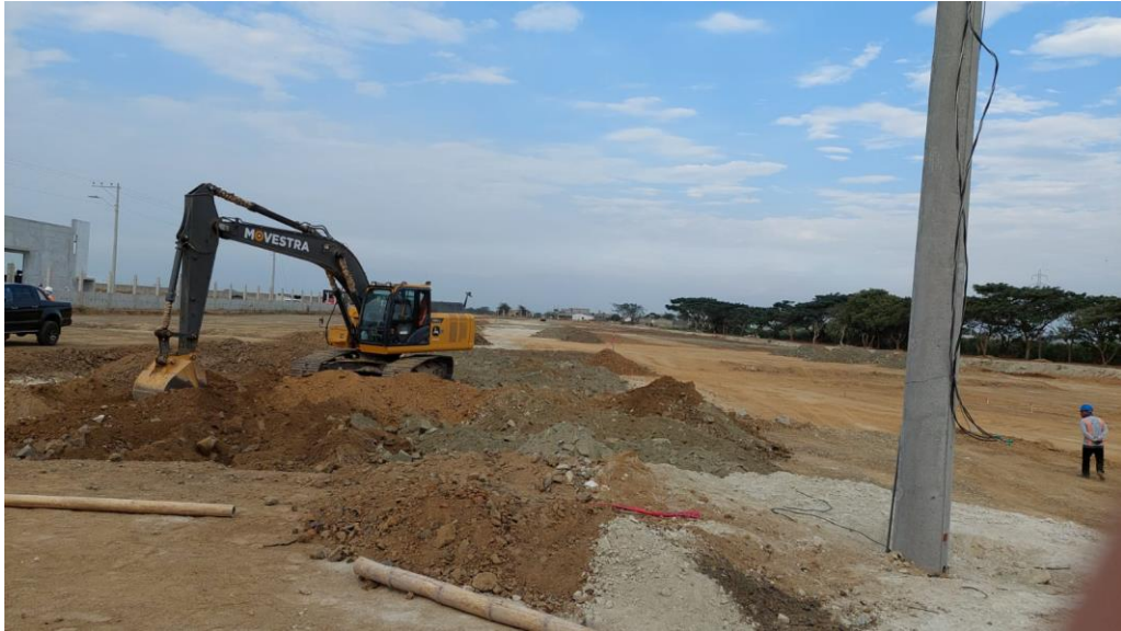
Imagen 42. Movimiento de tierra Elaborado por: Pozo, C. (2021)
