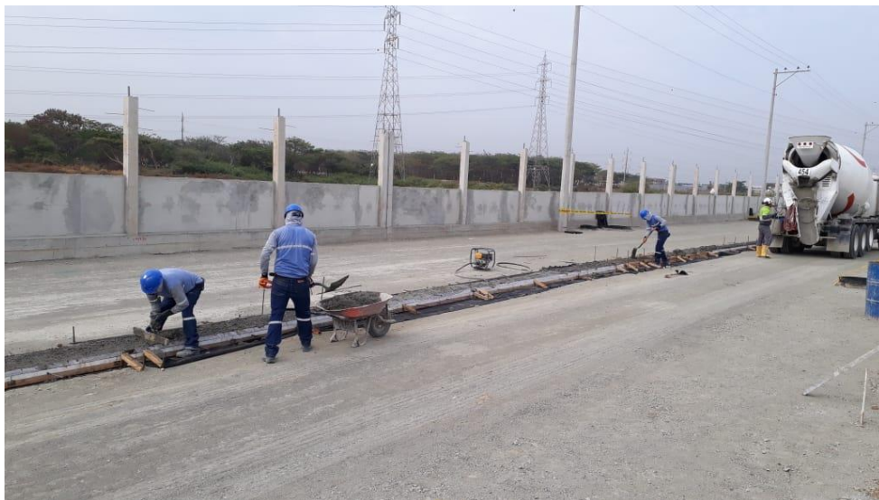
Imagen 49. Fundido de cuneta Elaborado por: Pozo, C. (2021)
