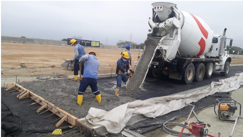
Imagen 53. Fundido de losa Elaborado por: Pozo, C. (2021)
