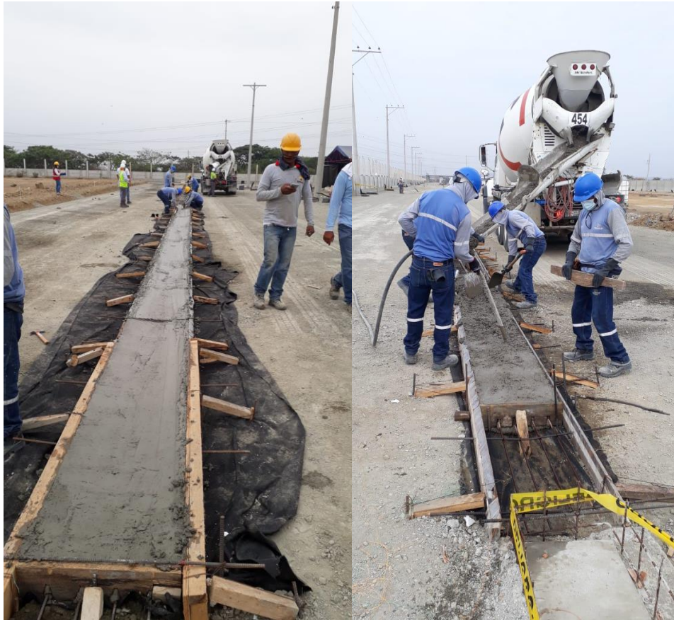
Imagen 50. Moldeo de cuneta Elaborado por: Pozo, C. (2021)
