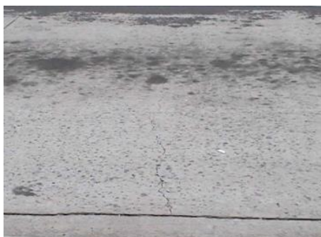
Imagen 25. Desgaste superficial Fuente. IBCH, 2012
