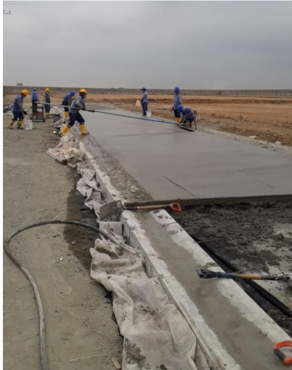
Imagen 55. Texturizado de hormigón Elaborado por: Pozo, C. (2021)
