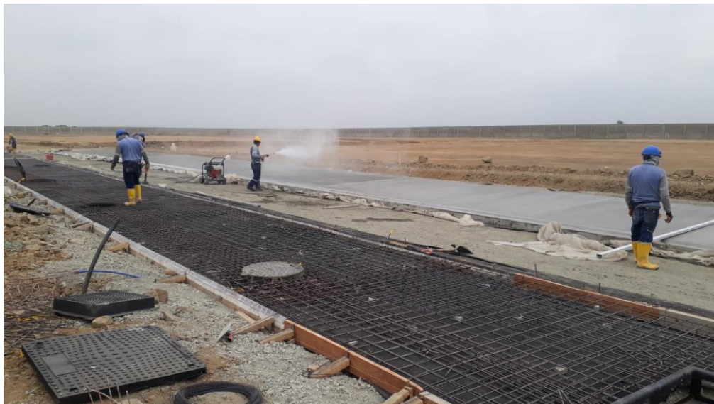
Imagen 57. Curado del hormigón Fuente: Pozo, C. (2021)
