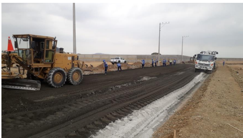
Imagen 45. Colocación de sub-base Elaborado por: Pozo, C. (2021)
