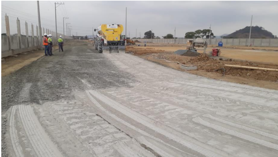
Imagen 46. Estabilización con cemento Elaborado por. Pozo, C. (2021)
