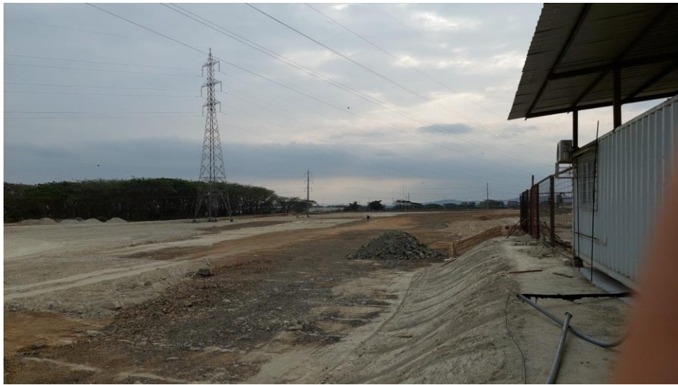
Imagen 40. Limpieza y desbroce Elaborado por: Pozo, C. (2021)
