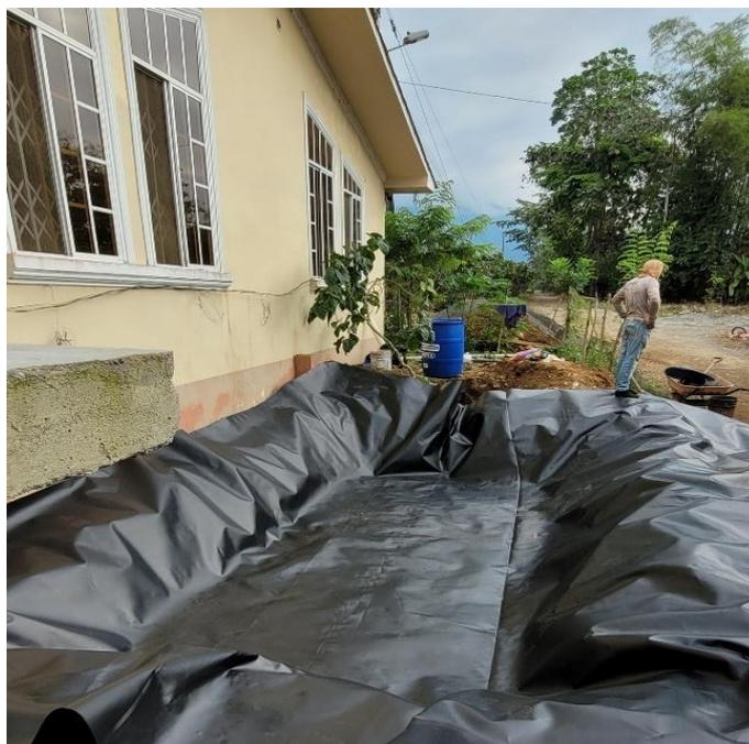
**Nota:** Impermeabilización del humedal con geomembrana de 0.5 mm de espesor
