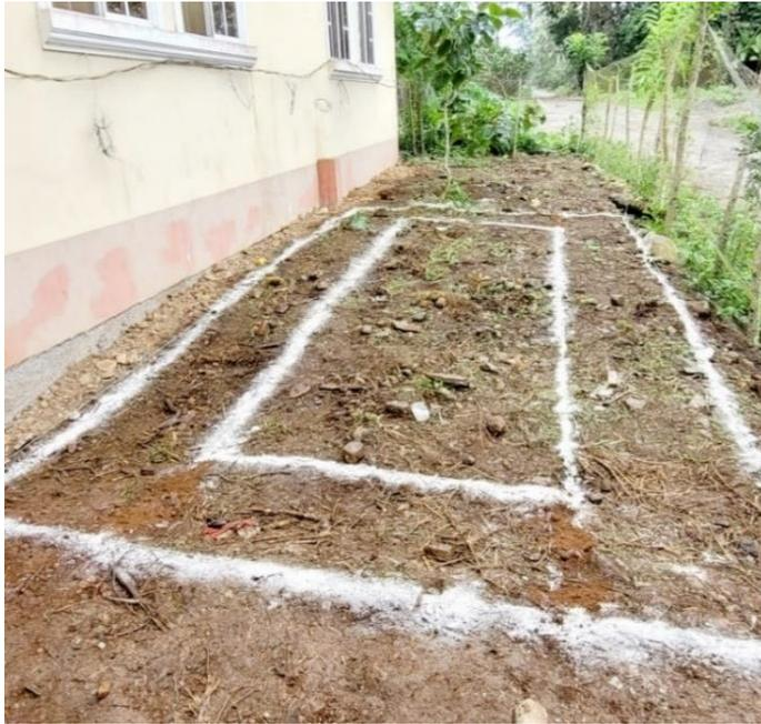
**Figura 22.** *Replanteo Total para Excavación*
