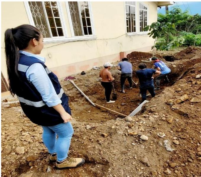
**Nota:** Para la conformación del talud se hizo uso de una guía de madera
