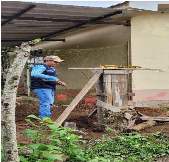
**Figura 27.** *Encofrado de la estructura de hormigón armado*
