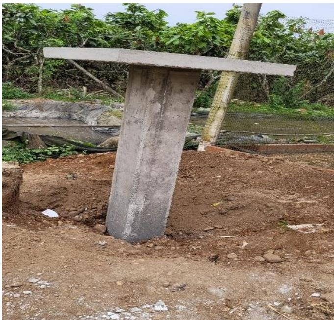
**Figura 28.** *Estructura de Soporte de Hormigón Armado para Tanque de 55 galones*
