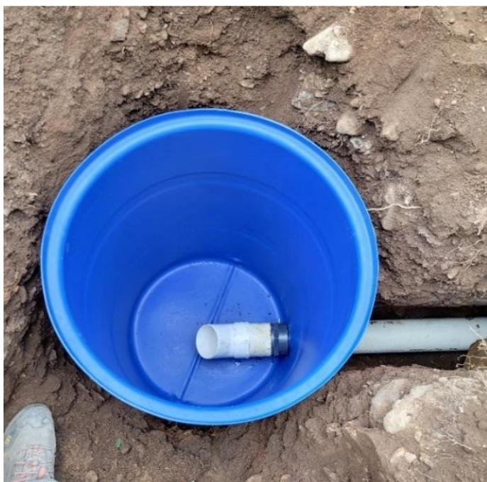
**Nota:** Se usó un codo de 45° para una tubería de 4 pulgadas.
