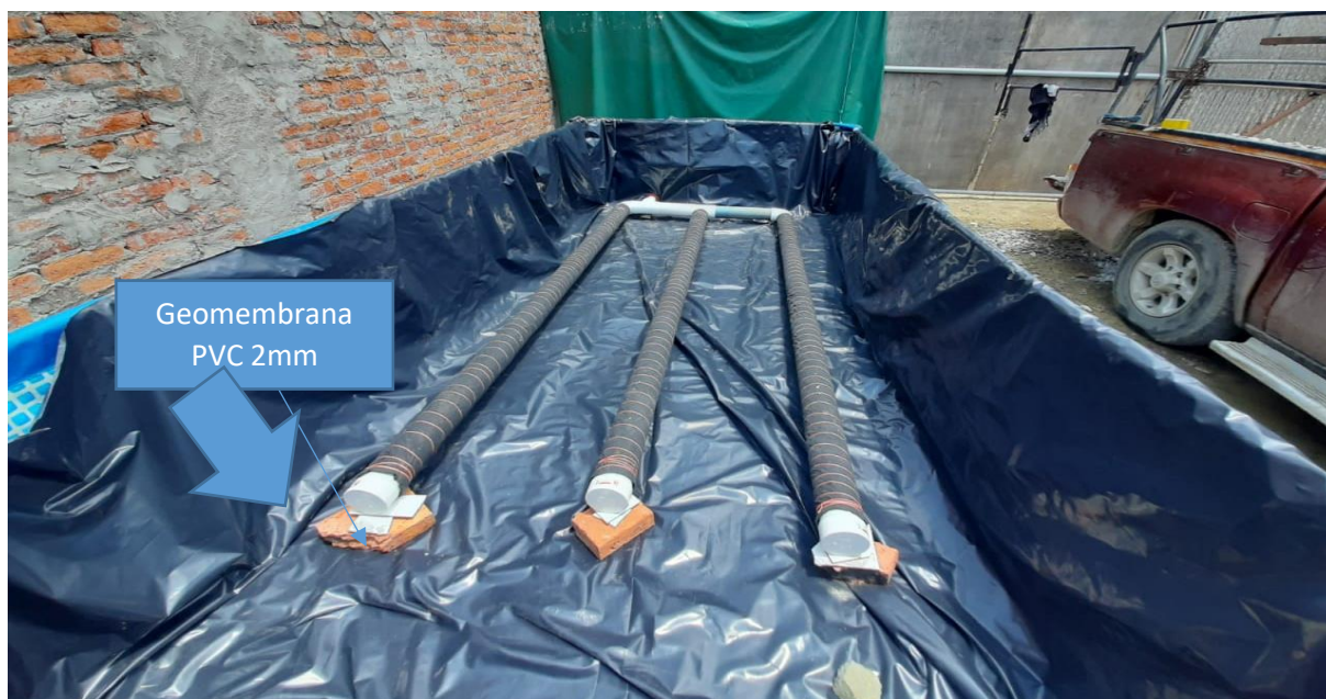
Figura 31. Impermeabilización de humedal artificial
