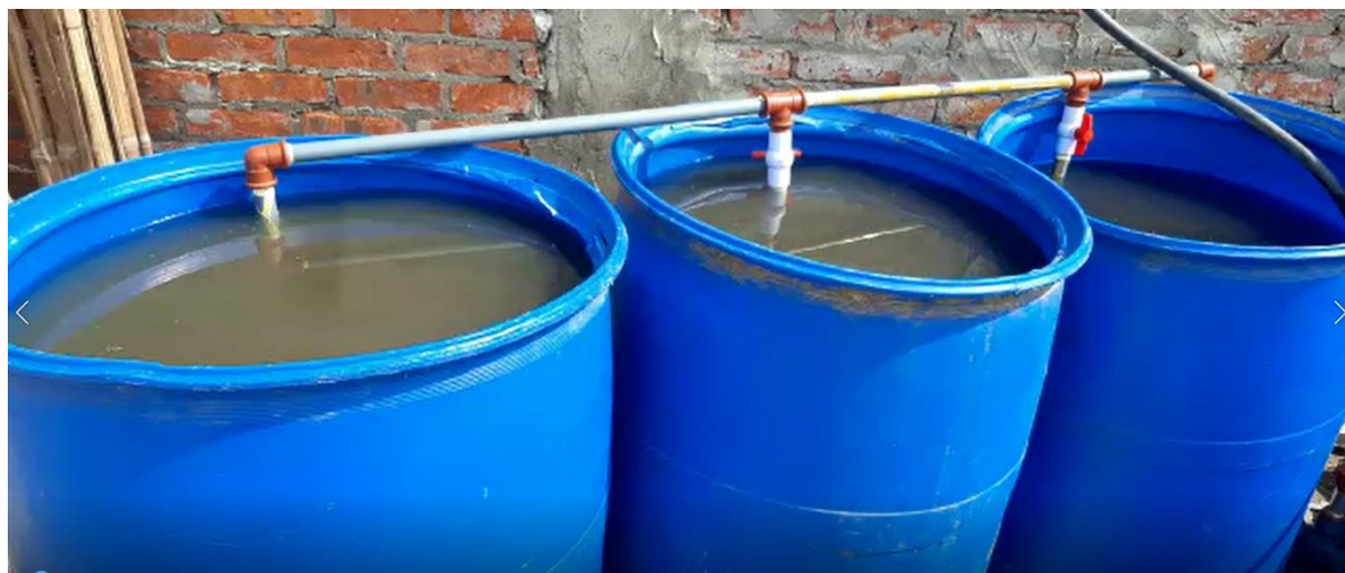
Figura 42. Prueba de funcionamiento
