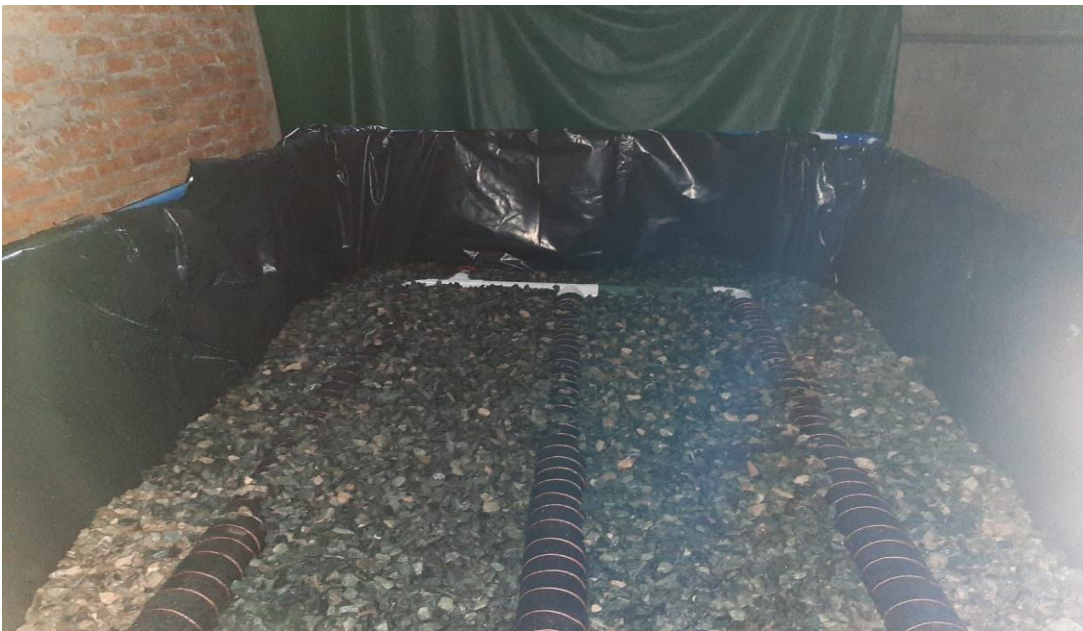
Figura 35. Tubos forrados con geotextil
