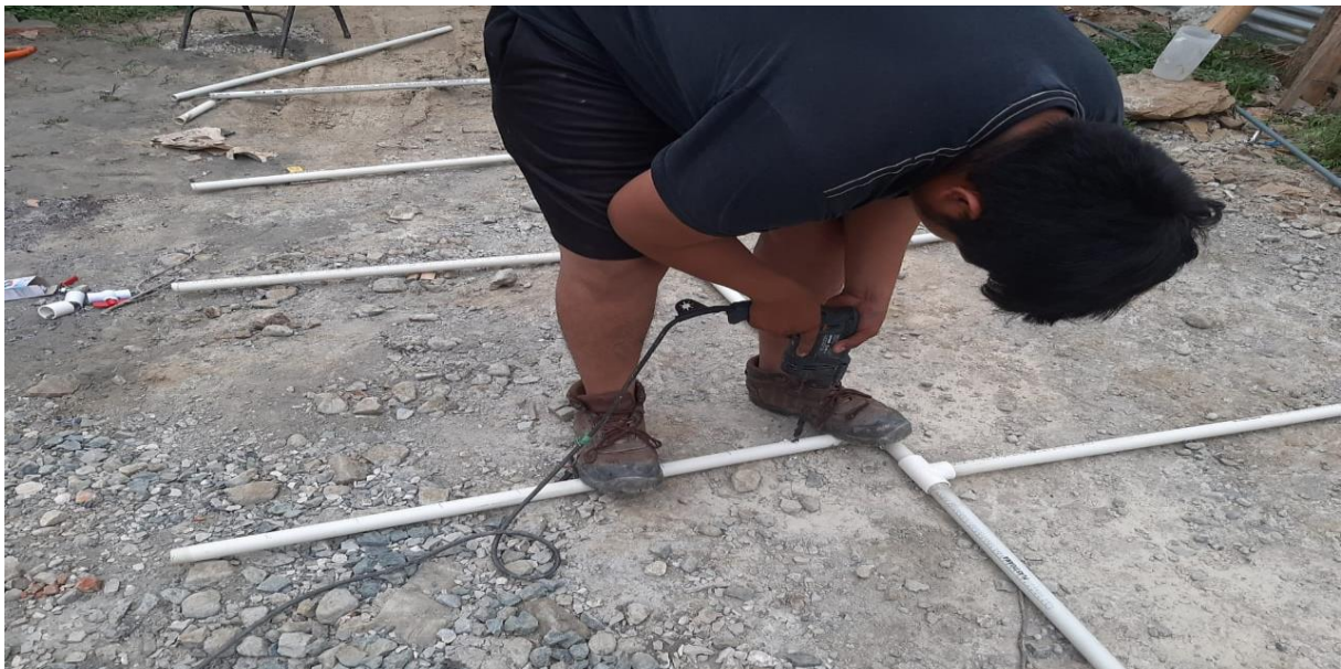
Figura 39. Construcción del sistema de riego flauta
