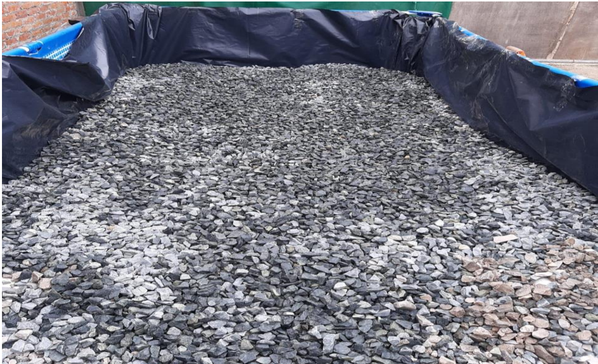
Figura 33. Colocación de la capa de piedra
