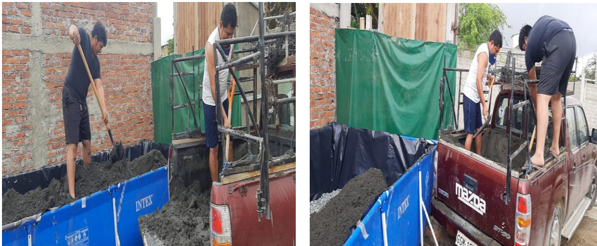
Figura 36. Colocación de la capa de arena
