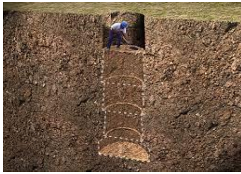
Figura 13 Pozo Excavado Fuente: (Gonzales, 2015)
