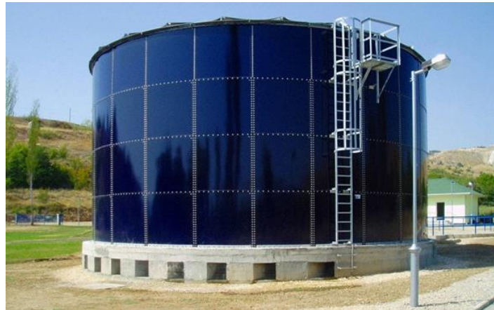
Figura 9 Tanque de almacenamiento
