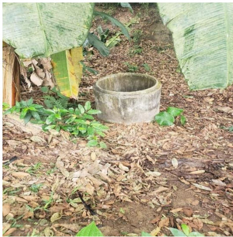
Figura 22 Pozo existente de Agua potable en el recinto Blanca Flor Autor: Aguayo, Heras 2022
