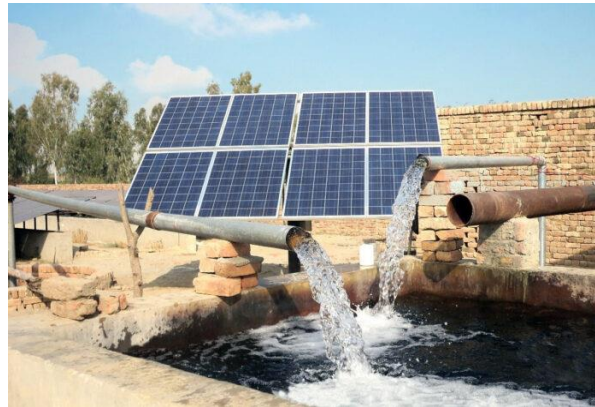
Figura 3 Sistema de Bombeo Solar
