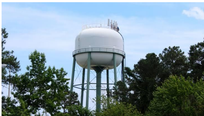
Figura 8 Tanque elevado Fuente: (Plaremesa, 2019)
