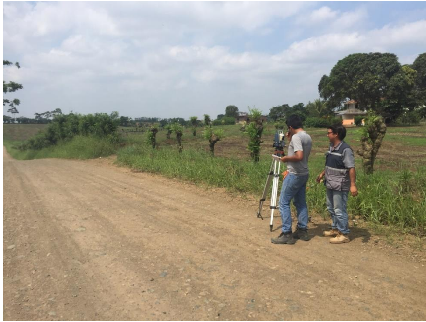
Ilustración 6 Levantamiento topográfico planimétrico utilizando la estación total.
