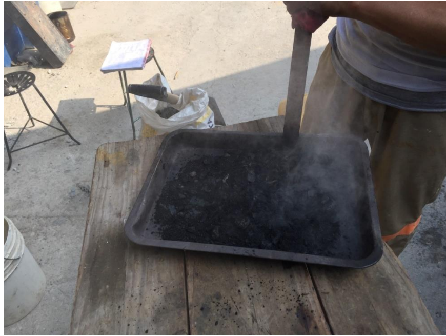
Ilustración 20 Resultado final de la mezcla para su posterior compactación.
