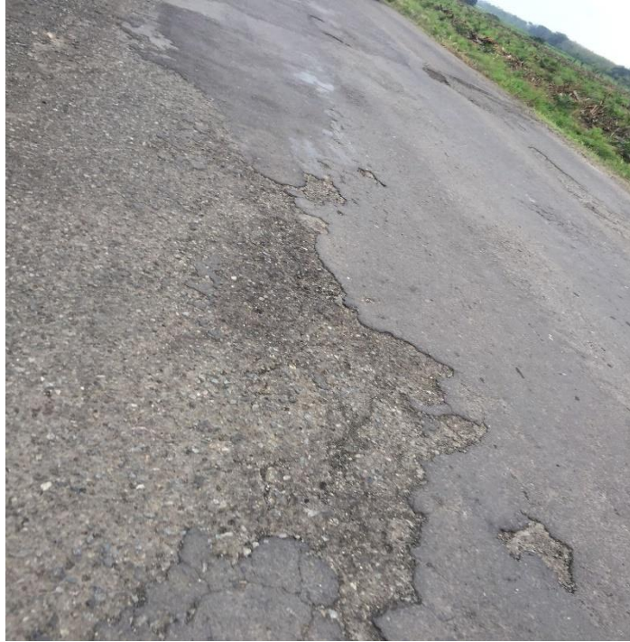
Ilustración 2 Irregularidades en la capa de rodadura. Elaborado por: López y Salazar (2022).
