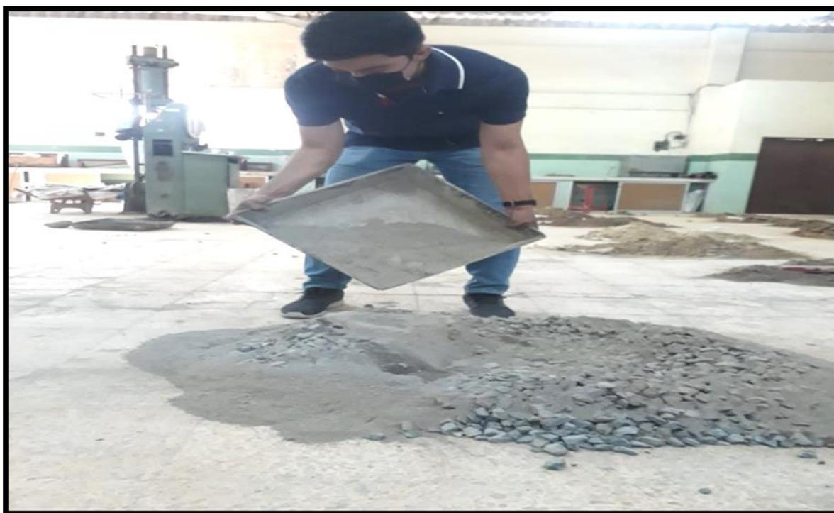
*Ilustración 27: Incorporación del cemento a la mezcla*
