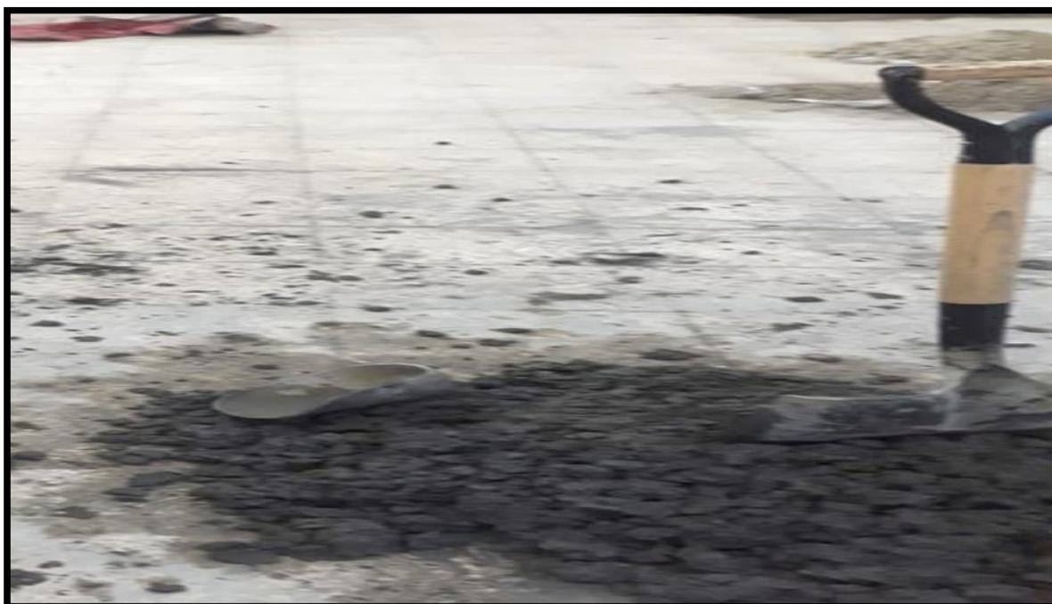
*Ilustración 24: Hormigón de 350 kg/cm<sup>2</sup>
