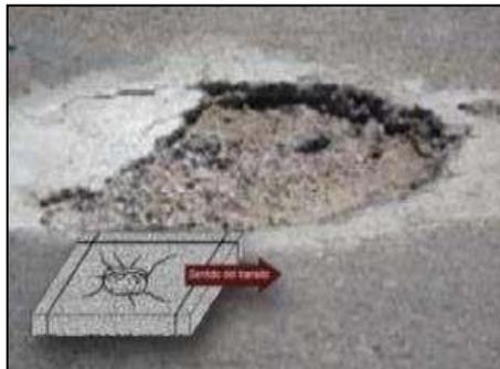
*Ilustración 4: Baches en la superficie de rodadura*
