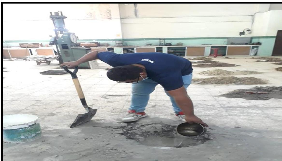
*Ilustración 22: Agrega agua a la mezcla seca*
