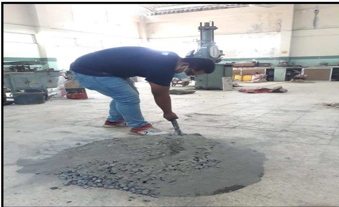
*Ilustración 21: Se mezcla en seco los agregados con el cemento*
