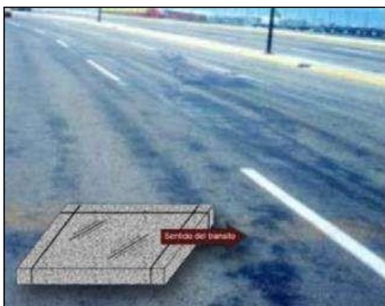
*Ilustración 6: Pulimiento de superficie de rodadura*
