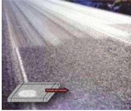
*Ilustración 3: Peladuras en superficies de rodaduras*
