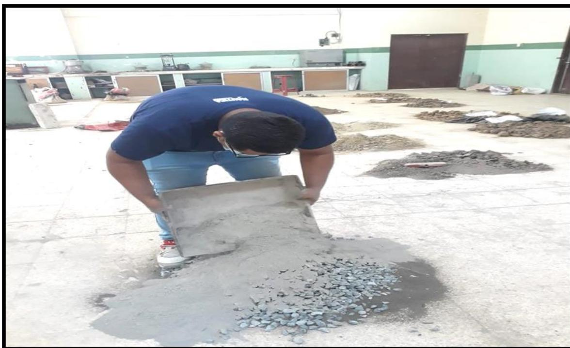
**Ilustración 20:** Se añade el cemento para la elaboración de hormigón de 350 kg/cm<sup>2</sup>
