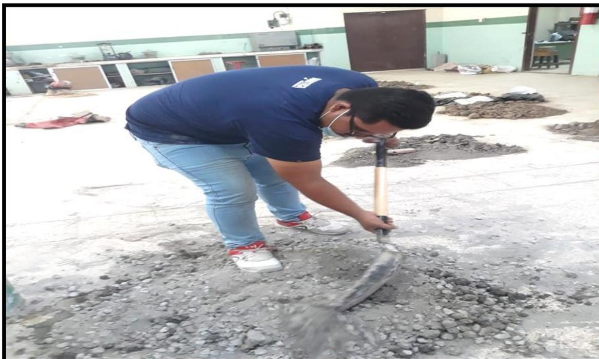
*Ilustración 23: Procede a mezclar para generar el hormigón de 350 kg/cm<sup>2</sup>
