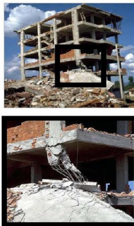
Figura 2. Daños ocasionados en las columnas, vigas, muros, etc de una edificación.
