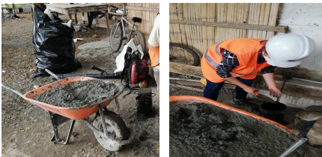
Figura 20: Mezcla del Hormigón tradicional f'c= 210\text{kg/cm}^2
