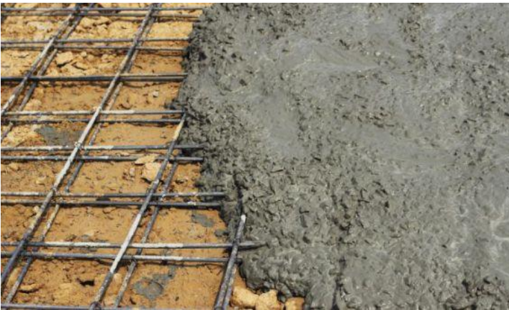
Figura 4. Mezcla de hormigón
