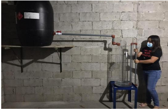
Ilustración 7: Colocación de Accesorio que une al Tanque Reservorio
