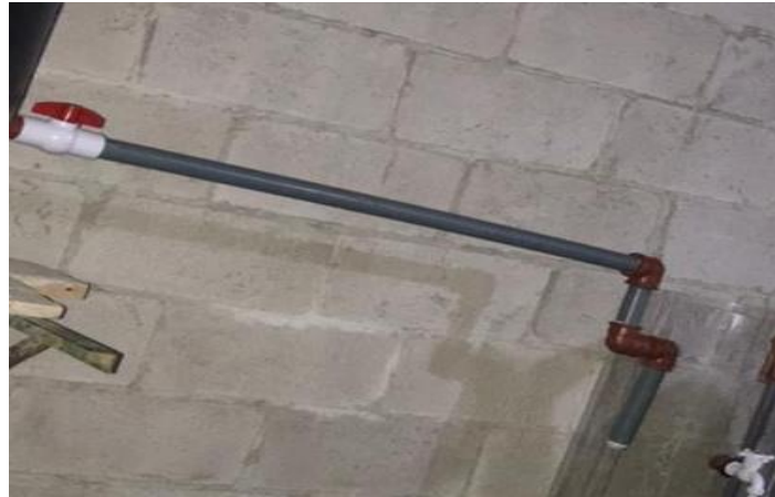
Ilustración 9: Conexión de Codo PVC
