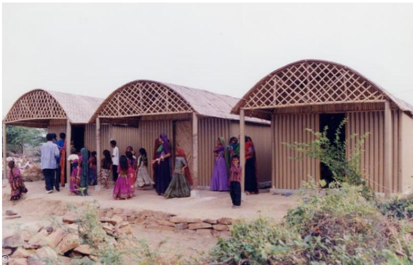
Figura 17. Casa de tubos de cartón, India Fuente: (ArchDaily, 2014)
