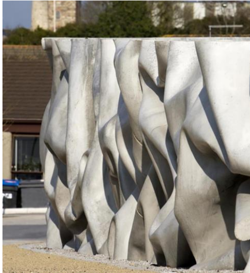
Figura 13. Obra de concreto utilizando encofrado flexible
