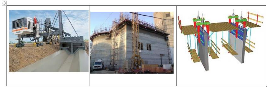
Figura 16. Imágenes de sistemas de encofrado deslizante
