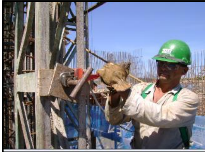
Figura 40. Imagen de alineación de guías verticales
