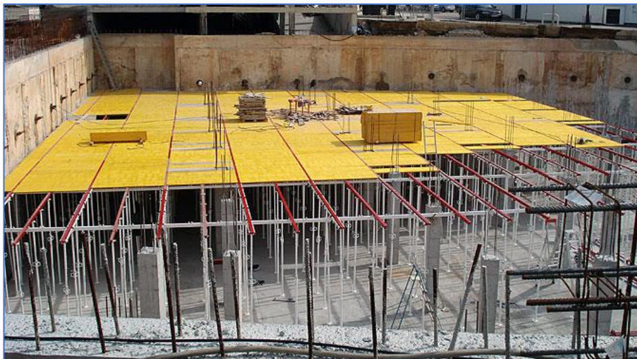
Figura 7. Modelo de encofrado horizontal
