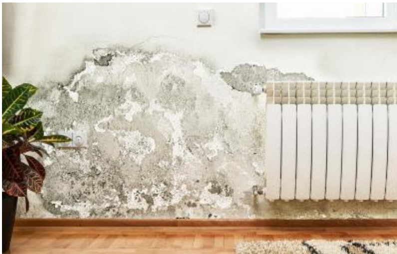
Figura 2: Humedad paredes frontales interiores – Costa Fuente: (Diario de Mallorca, 2017)
