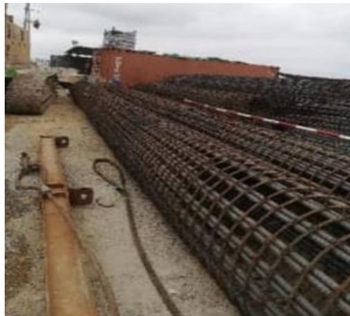
Figura 37. Armadura de pilote en barcaza
