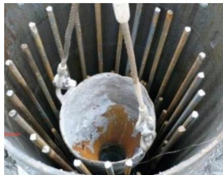
Figura 40. Colocación de embudo
