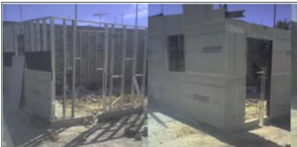
*Figura 6.* Sistema constructivo concreto reforzado con fibras de acero reciclado
