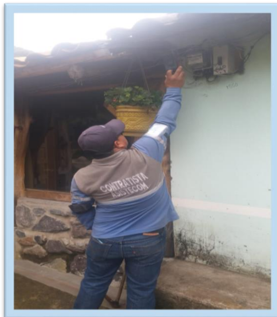
Toma de fotos al medidor Elaborado por: Meza y Zoller (2021)
