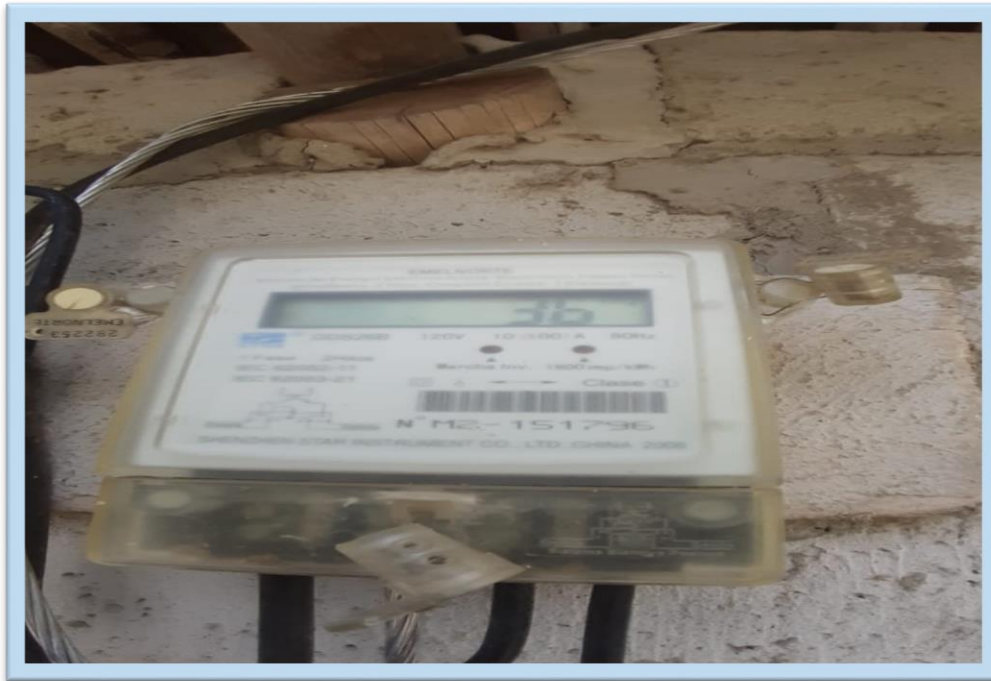
Medidor sin caja antifraude Elaborado por: Meza y Zoller (2021)
