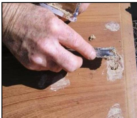
Figura 30. Masillado de la madera Fuente: Paint (2018)
