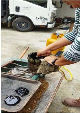
**Figura 8:** *Calentamiento de asfalto tradicional*
