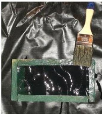
Figura 28 Aplicación de aceite quemado a moldes de adoquines
