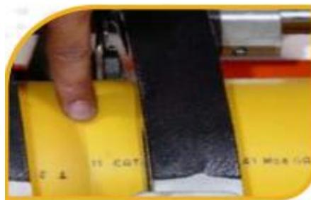
**Figura 41:** Procedimiento para la soldadura de termofusión a tope
