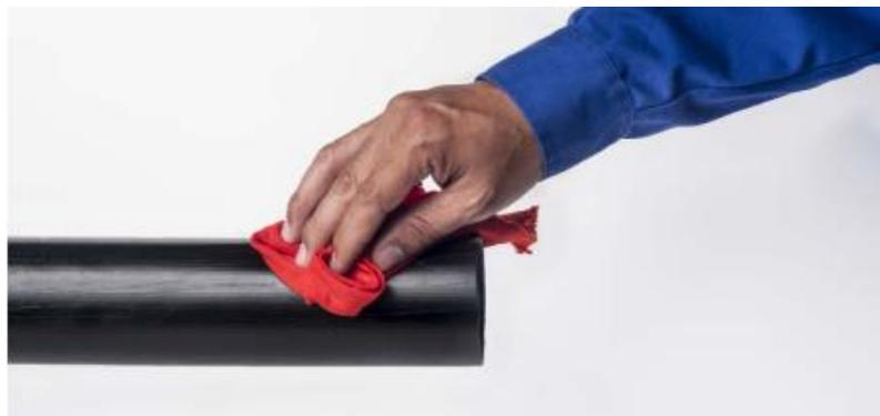
**Figura 18:** Limpie y secar bien el extremo de la tubería.
