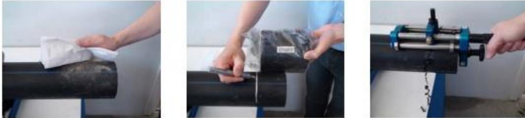
**Figura 16:** Limpiar, marcar y raspar.
