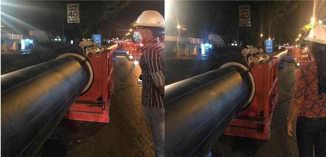
**Figura 134:** Inspección de las fusiones
