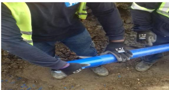
*Figura 118: Limpieza con alcohol de uno de los extremos del tubo, post raspado del mismo*
