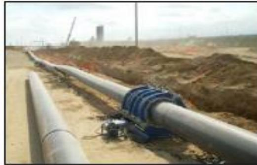
**Figura 23:** Máquina de soldar a tope de obra.
