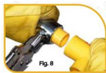
**Figura 67:** Procedimiento para la soldadura de termofusión a socket
