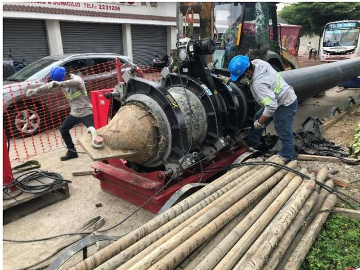
*Figura 130: Adecuada presión de calentamiento*
