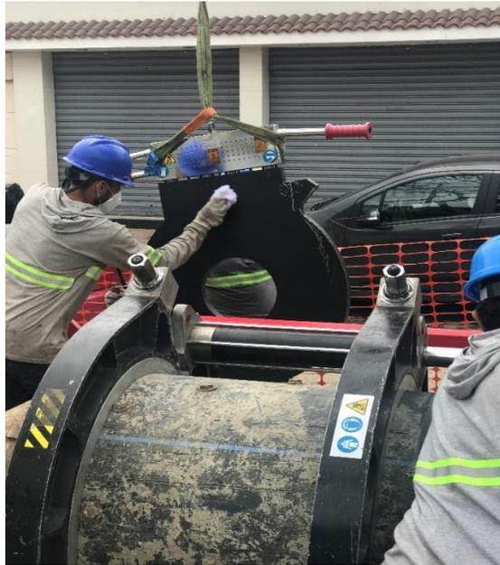
**Figura 127:** Plancha de calentamiento
