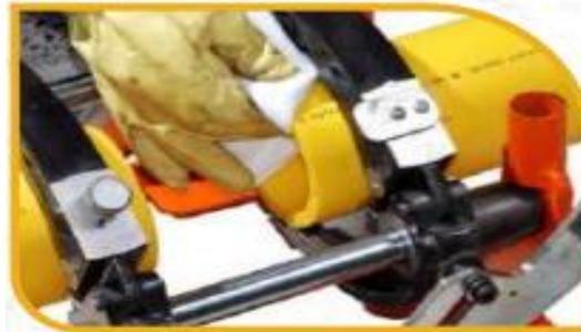
**Figura 38:** Procedimiento para la soldadura de termofusión a tope
