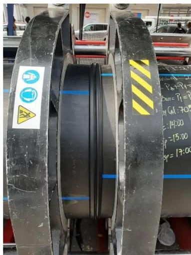
**Figura 132:** Unión de los ambos extremos de la tubería
