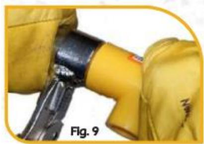
**Figura 68:** Procedimiento para la soldadura de termofusión a socket
