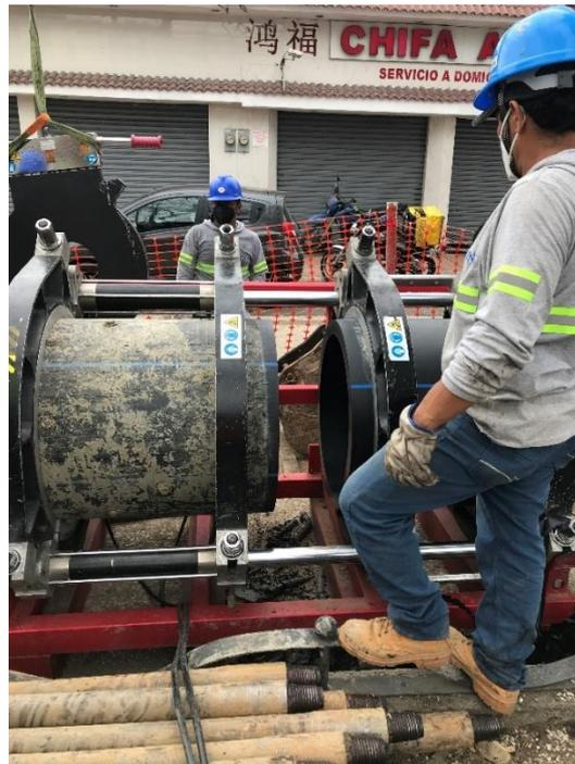
*Figura 125: Colocación del carro alineador*
