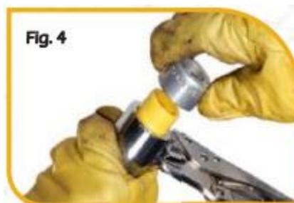
**Figura 63:** Procedimiento para la soldadura de termofusión a socket
