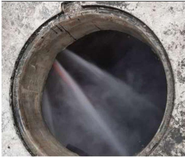
Figura 17.- Limpieza de la red de alcantarillado. Elaborado por: Velasco (2021).
