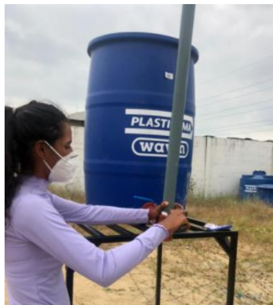
Ilustración 27. Instalación de llave esférica y tubería de 1 ½”.
