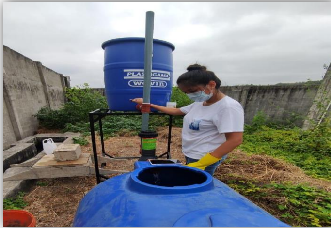
Ilustración 39. A la espera del proceso de desinfección a 45 minutos con las pastillas de cloro.
