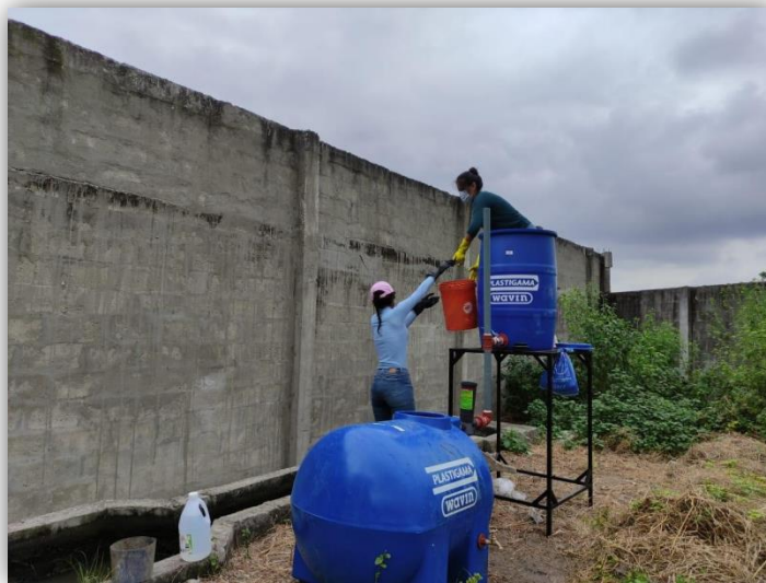
Ilustración 48. Llenado del tanque elevado con 270 lts de agua residual.
