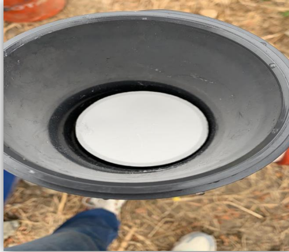
Ilustración 37. Pastillas de cloro dentro del Clorinador. Elaborado por: Arana & Mancero (2021).
