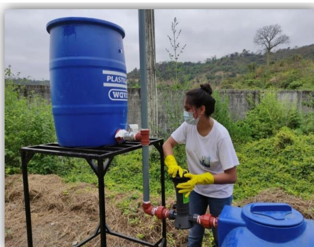
Ilustración 36. Dosificación de las pastillas de cloro dentro del clorinador. Elaborado por: Arana & Mancero (2021).
