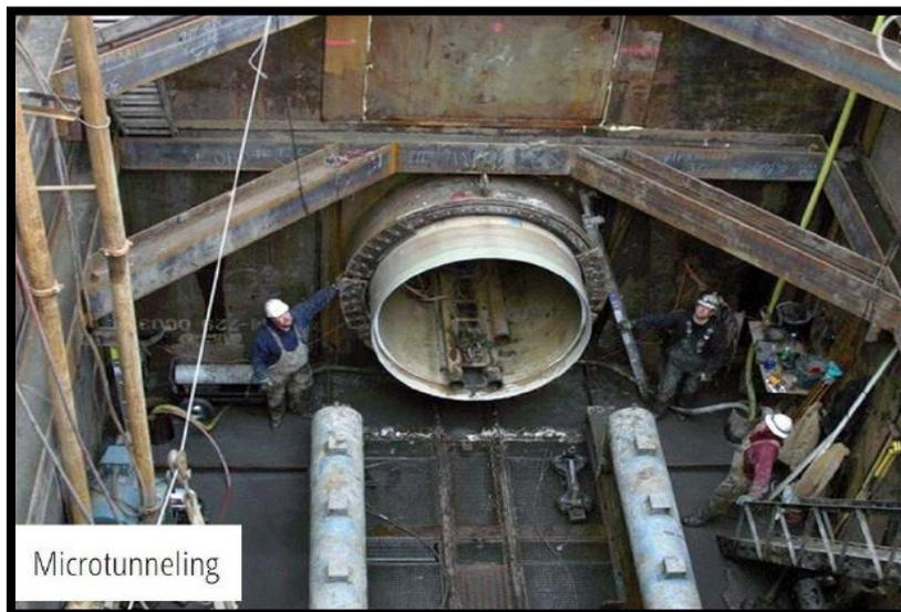
*Ilustración 15.* Pozo de salida de la microtuneladora.
