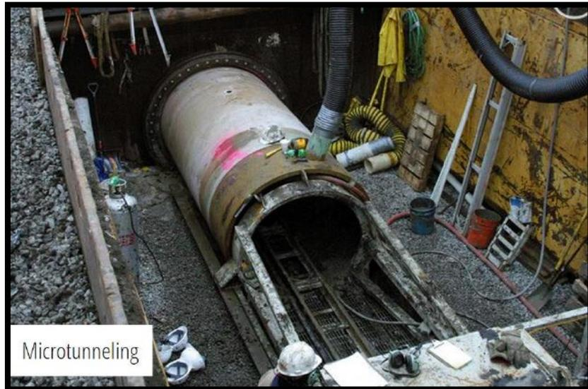
*Ilustración 14.* Pozo de lanzamiento de la microtuneladora.
