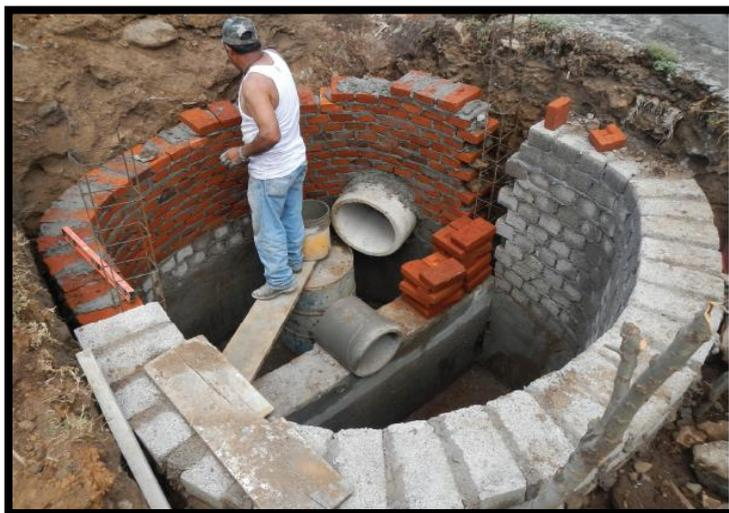
*Ilustración 24.* Pozo de visita red de alcantarillado sanitario.
