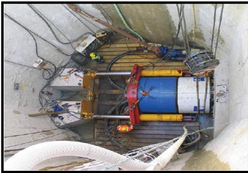
*Ilustración 8.* Sistema de empuje en pozo de lanzamiento.
