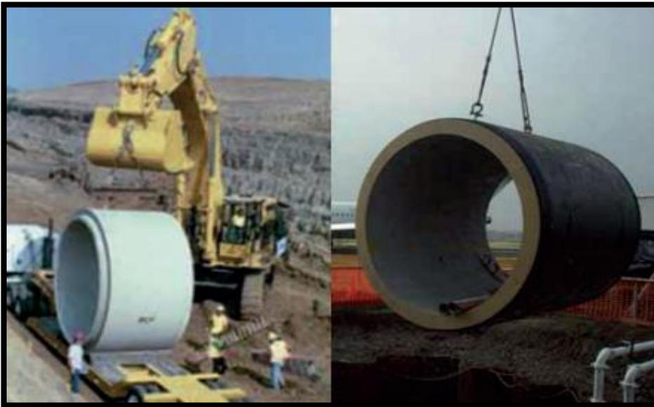
*Ilustración 23.* Tuberías de concreto reforzado para una red de saneamiento.
