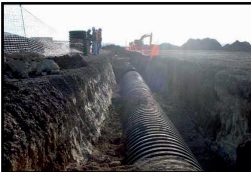
*Ilustración 21.* Relleno de sistema de saneamiento para aguas servidas.
