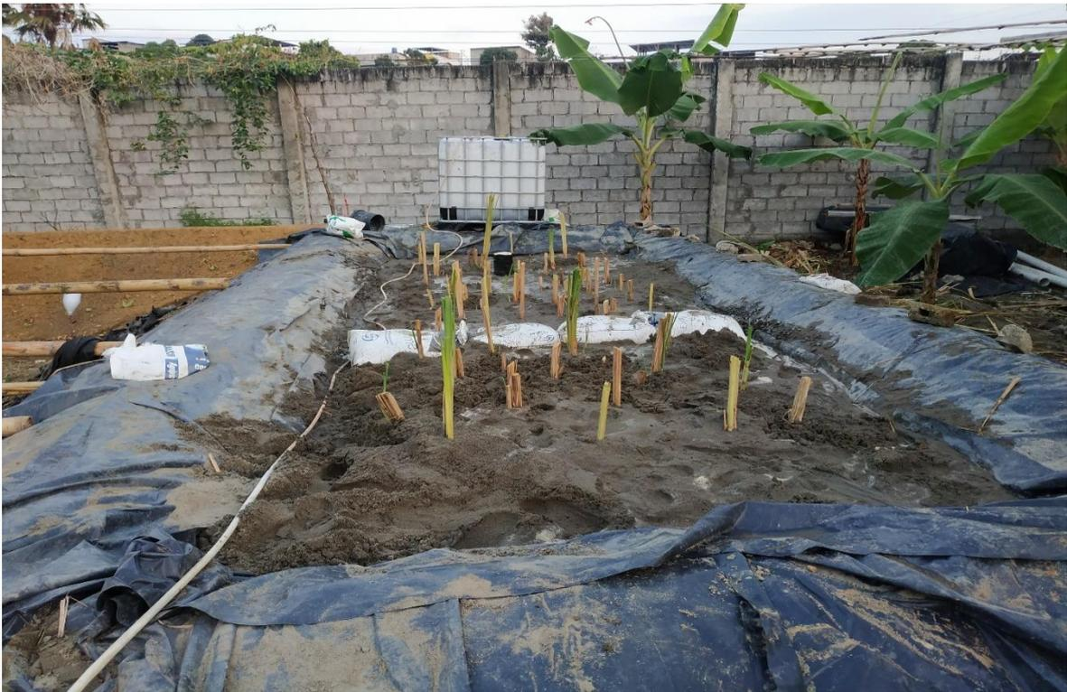
**Figura 31.-** Reforestación del Pantano Seco Artificial con el Junco de Río. Elaborado por: Orlando Velásquez López, 2021.
