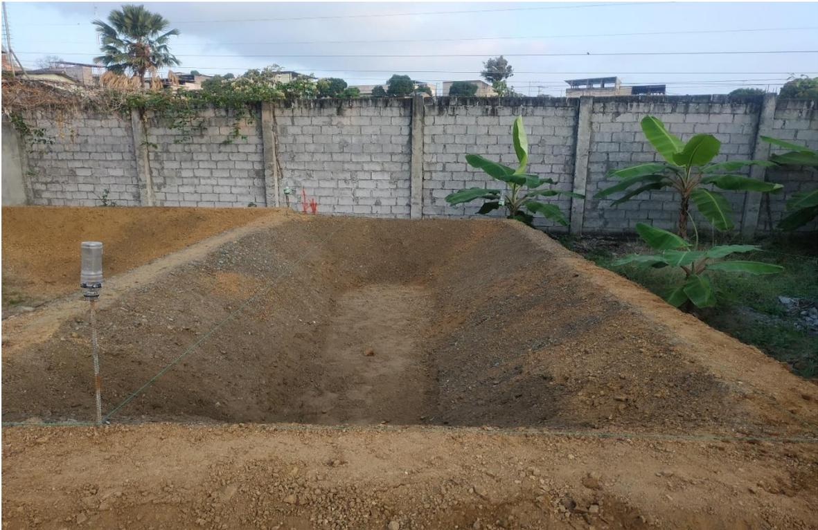
**Figura 26.-** Conformación de Talud del Pantano Seco Artificial. Elaborado por: Orlando Velásquez López, 2021.
