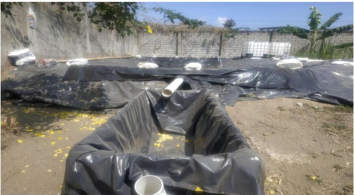
**Figura 23.-** Impermeabilización de la Estructura. Elaborado por: Orlando Velásquez López, 2021.
