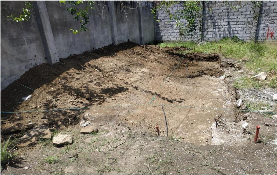
**Figura 18.-** Conformación de Talud de la Laguna de Oxidación. Elaborado por: Orlando Velásquez López, 2021.
