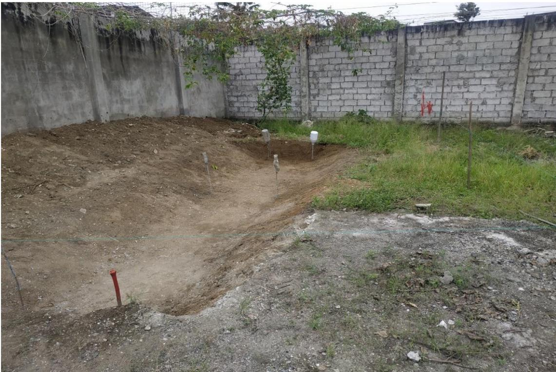
**Figura 19.-** Conformación de Solera de la Laguna de Oxidación. Elaborado por: Orlando Velásquez López, 2021.
