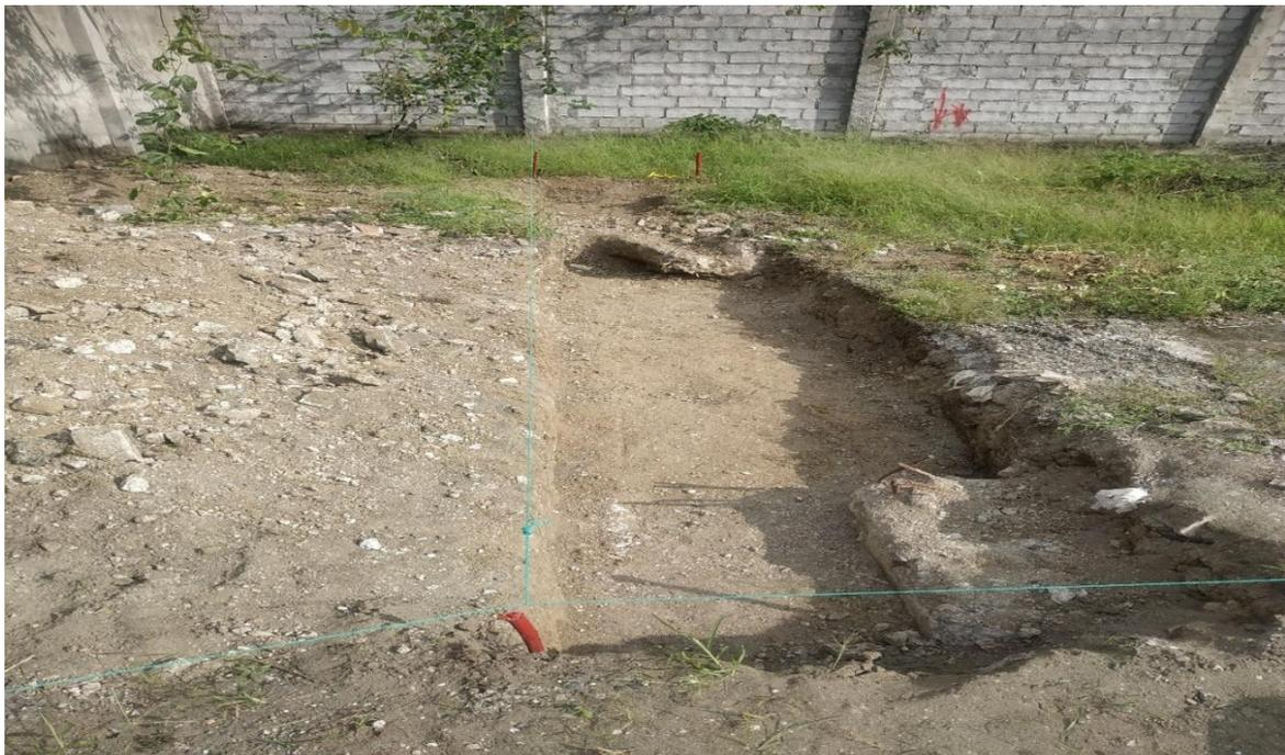
**Figura 17.-** Inicio de Construcción de Laguna de Oxidación. Elaborado por: Orlando Velásquez López, 2021.
