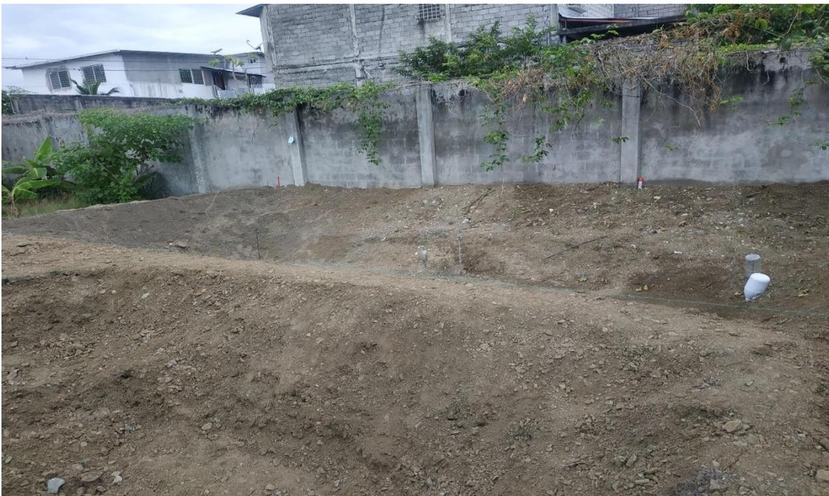
**Figura 21.-** Conformación de Corona y Talud de la Laguna de Oxidación. Elaborado por: Orlando Velásquez López, 2021.
