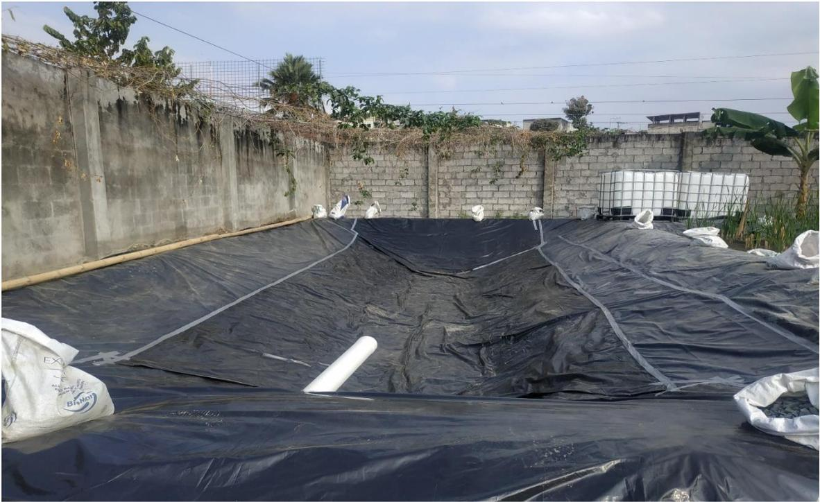
**Figura 22.-** Impermeabilización de Solera, Corona y Talud de la Laguna de Oxidación. Elaborado por: Orlando Velásquez López, 2021.
