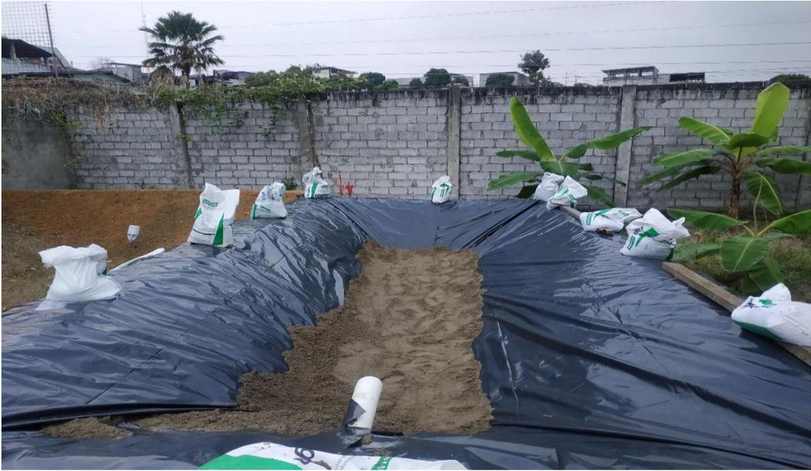
**Figura 28.-** Impermeabilización de Solera, Corona y Talud del Pantano Seco Artificial. Elaborado por: Orlando Velásquez López, 2021.
