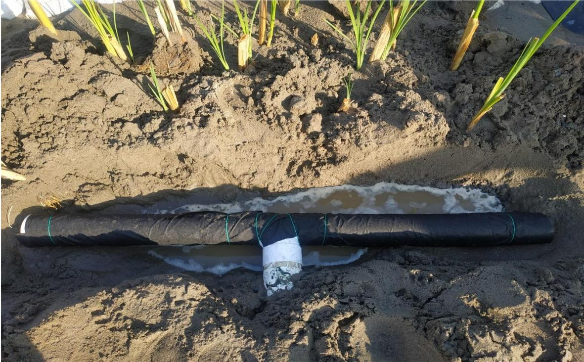
**Figura 34.-** Instalación del Filtro en el Pantano Seco Artificial. Elaborado por: Orlando Velásquez López, 2021.
