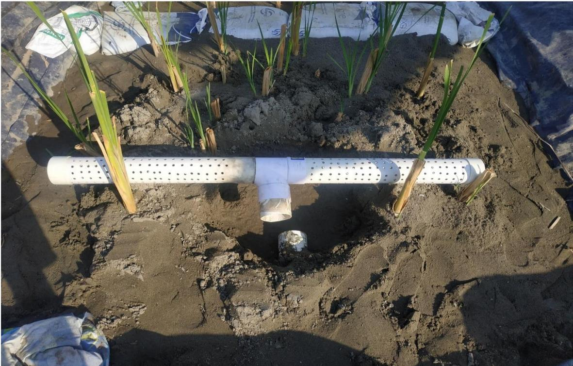
**Figura 33.-** Filtro para el Pantano Seco Artificial. Elaborado por: Orlando Velásquez López, 2021.
