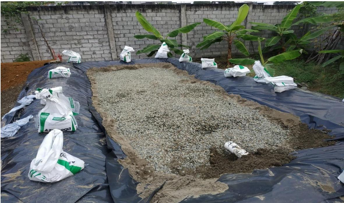
**Figura 29.-** Instalación de Grava y Arena en el Pantano Seco Artificial. Elaborado por: Orlando Velásquez López, 2021.
