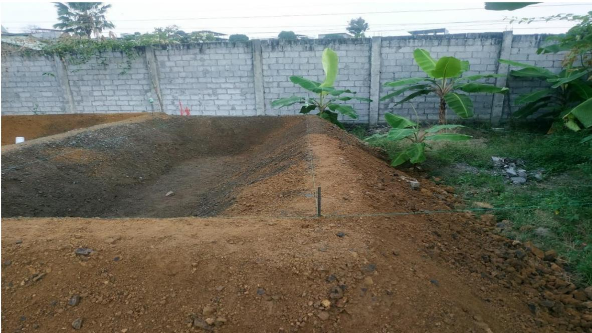
**Figura 27.-** Conformación de Corona del Pantano Seco Artificial. Elaborado por: Orlando Velásquez López, 2021.
