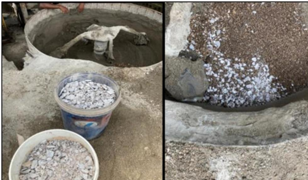
**Figura47.** Colocación de las disociaciones (Colocación del Polietileno) en la mezcladora
