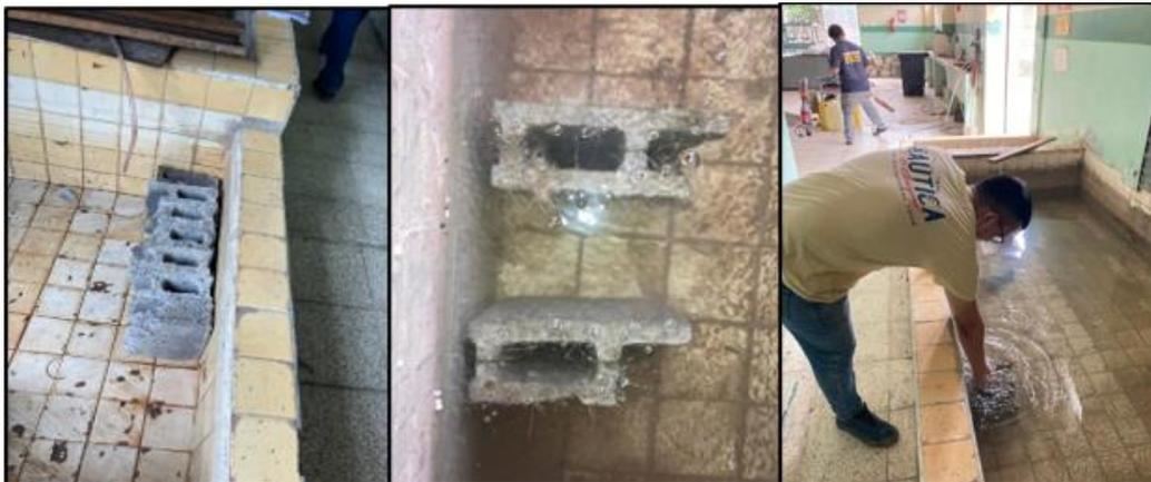
**Figura56.** Colocación de bloques en piscina.
