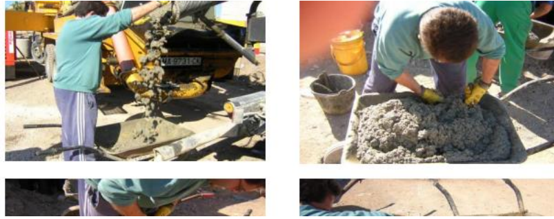
Figura 13: Ensayo de cono de Abrams para la medida de la consistencia.
