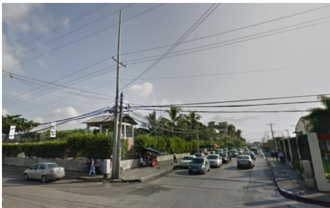
Ilustración 41: Estado de la infraestructura en la Avenida Juan Tanca Marengo.
