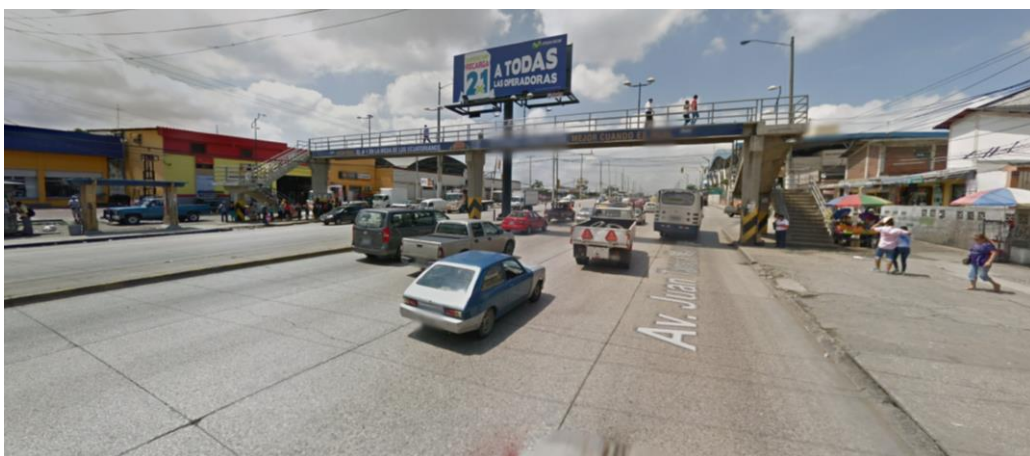
Ilustración 5: Estado de aceras y antiguo paso peatonal en ciudadela Martha Bucarám de Roldós, Avenida Juan Tanca Marengo km 5. Fuente: (Google Maps, 2020)
