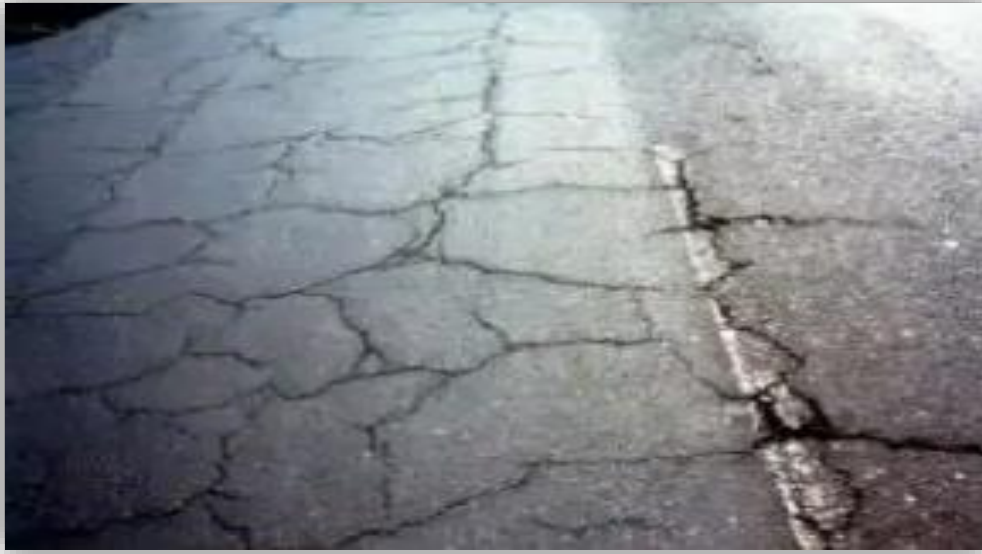
Figura 10 En bloque, en malla o en retícula. Fuentes: (Leon, 2016)
