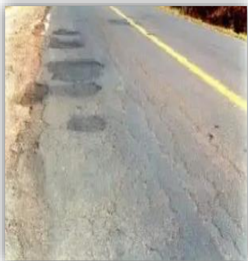
Figura 18 Longitudinal Fuentes: (Leon, 2016)
