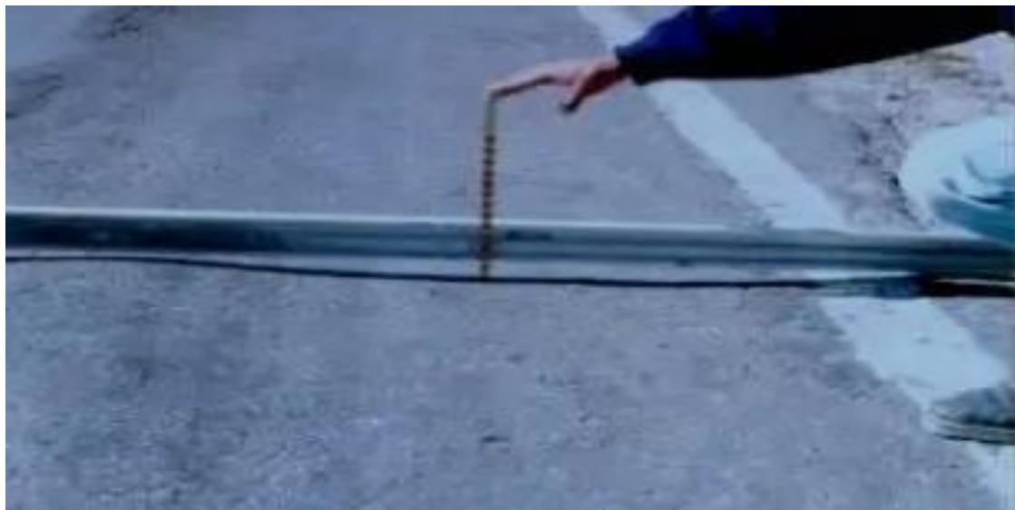
Figura 22 Ahuellamiento
