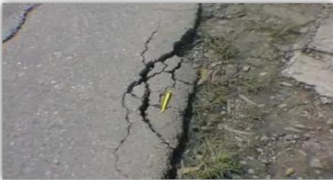
Figura 15 Desintegración de bordes Fuentes: (Leon, 2016)
