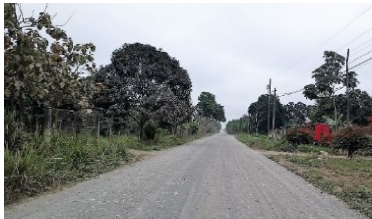
Figura 14 Acceso al terreno por vía lastrada conectada desde la av. Alfredo Adum Elaborado por: Maridueña & Matamoros (2020)
