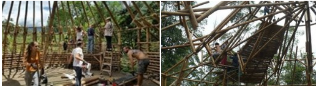
Figura 37 Proceso: construcción de viviendas, estructura natural madera, caña o bambú, adaptada a la topografía.
